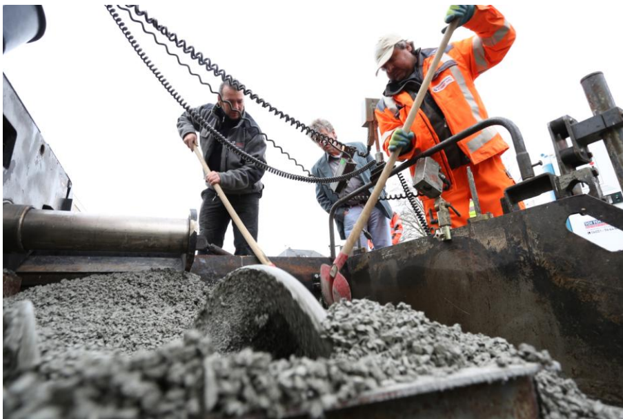
Den Einbau des Betons übernahm eine Asphaltstraßenbaukolonne. Foto: BetonBild
