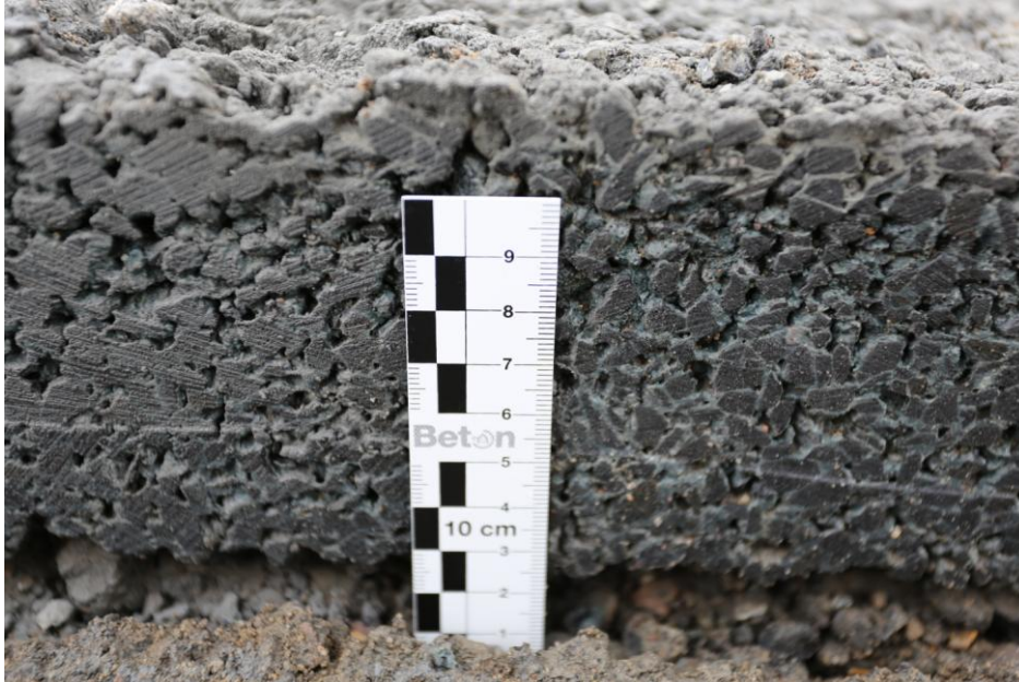
Offenporiger, wasserdurchlässiger Beton als Deckschicht im Detail. Foto: BetonBild
