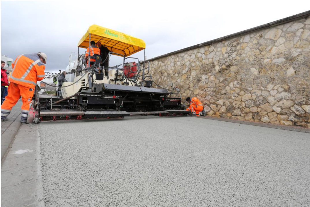
Beim Einbau des Dränbetons kam ein modifizierter Asphalt-Straßenfertiger zum Einsatz. Foto: BetonBild
