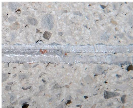
Der Überlappungsbereich bei CEMflex VB (nur 5 cm) verschließt sich bei Wasserzutritt automatisch. Dieser Vorgang geht extrem schnell, d. h. in wenigen Stunden von statten (aktive Kristallisation + aktive Versinterung)
