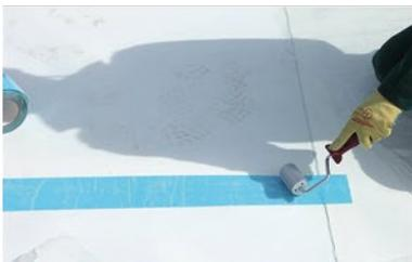
Querstöße  $\geq 7,5$  cm überlappen und mittig mit dem Preprufe Tape überkleben, anschließend festrollen
