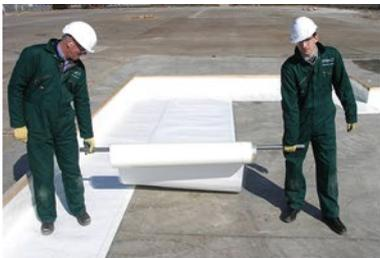
Preprufe Folien mit der entfernbaren Schutzfolie noch oben verlegen
