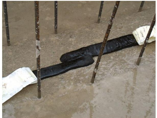
SynkoElast wird einfach in den frischen Beton verlegt. Durch Verschmelzung mit dem Beton bei der Hydratation wird die Dichtwirkung erreicht.
