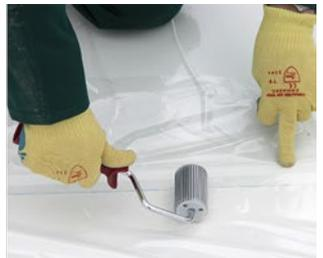
Schutzfolie im Überlappungsbereich abziehen und die beiden Lagen unter Druck zusammen kleben
