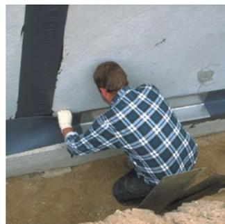
Verlegung der Swelltite-Streifen in der Bentoseal-Spachtelmasse.
