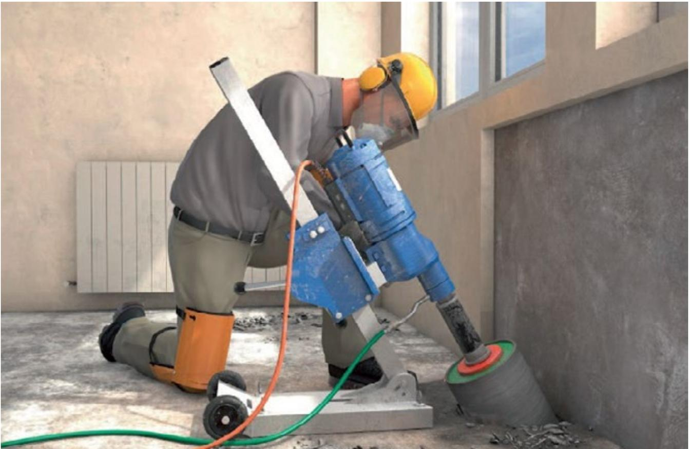
Abb. 40 PSA bei Betonbohrarbeiten
