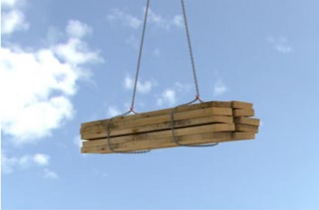
Abb. 79 Kettengehänge im Schnürgang
