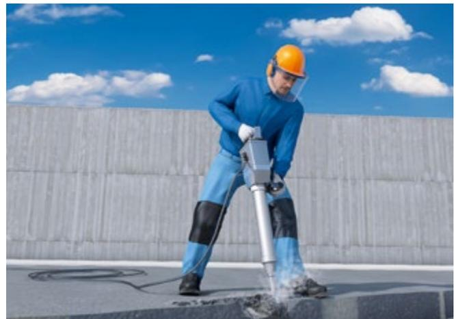
Abb. 39 Abbrucharbeiten mit geeigneter PSA
