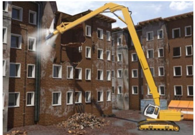
Abb. 84 Abbruchbagger mit Longfrontausrüstung
