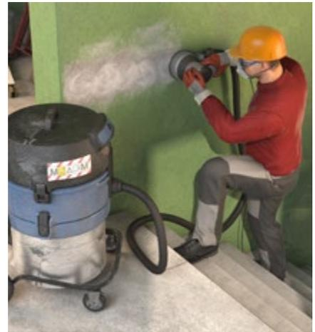
Abb. 10 Bau-Entstauber
