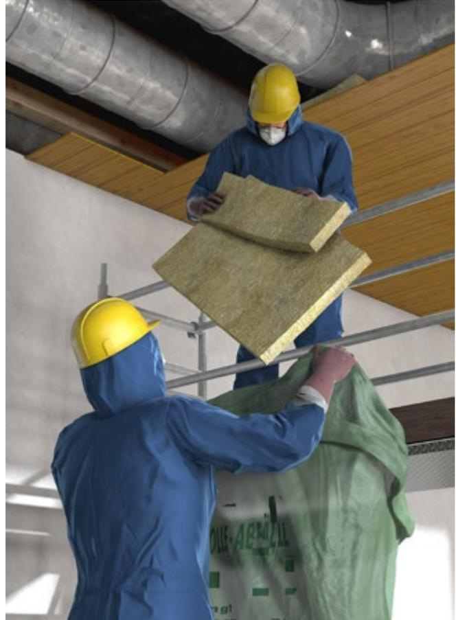
Abb. 11 Ausbau von Dämmplatten
