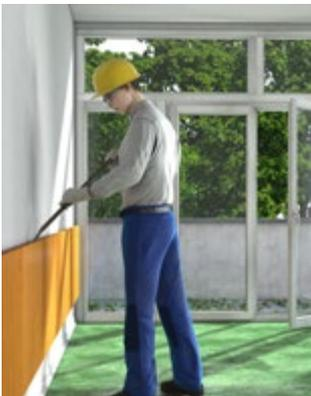
Abb. 89 Ausbau Wandverkleidung
