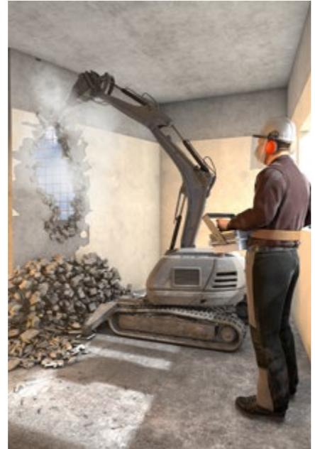
Abb. 88 ferngesteuertes Abbruchgerät
