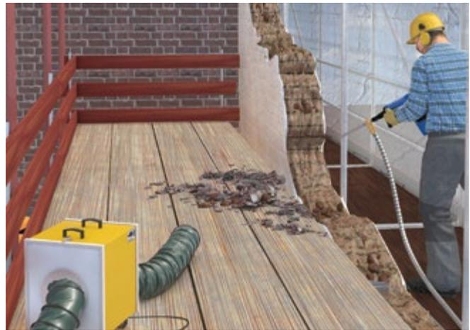
Abb. 4 Absturzsicherung durch Seitenschutz bzw. durch Fassadengerüst
