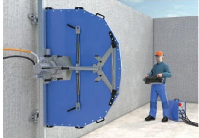
Abb. 105 Betonsägearbeiten
