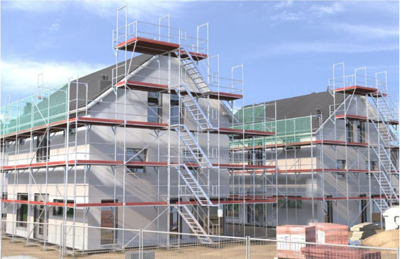
Abb. 53 fachgerechter Zugang zum Gerüst
