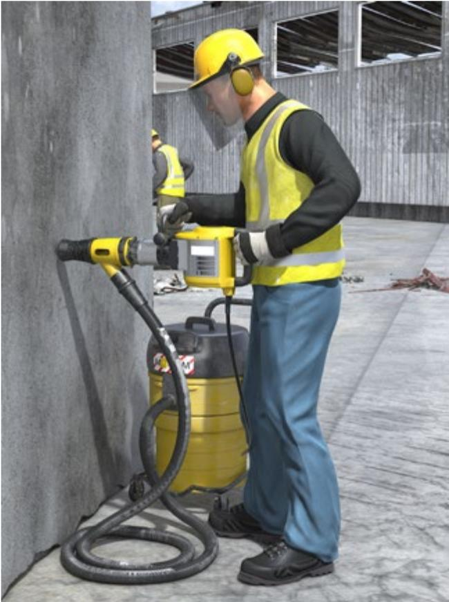
Abb. 85 Bohrhammer mit Absaugung
