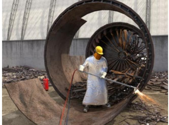
Abb. 115 Brennschneidarbeiten
