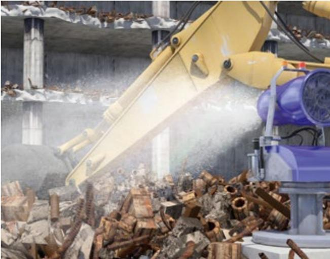
Abb. 98 Staubbindeanlage
