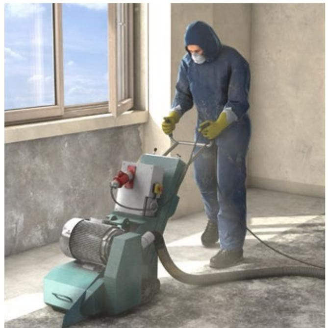
Abb. 16 Abschleifen PAK-haltiger Kleber
