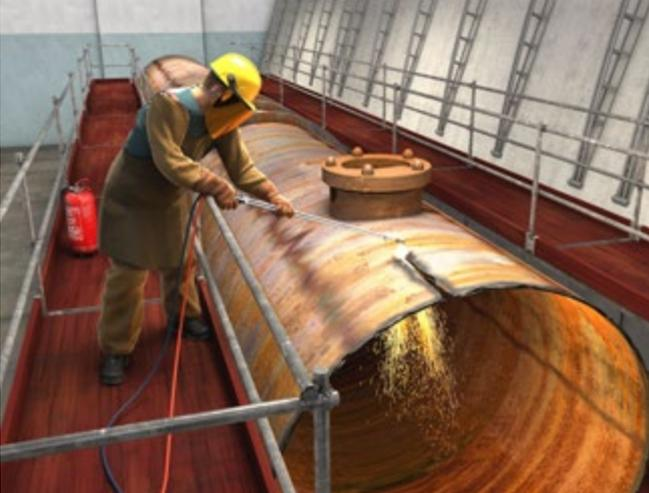
Abb. 114 Rückbau Rohranlage
