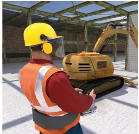
Abb. 95 Ferngesteuerte Abbruchmaschine
