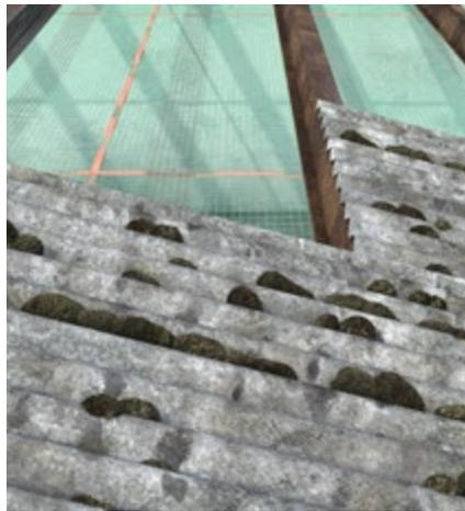
Abb. 9 Asbestzementwellplatten
