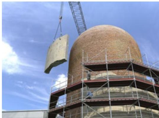
Abb. 109 Rückbau einer Gebäudehülle
