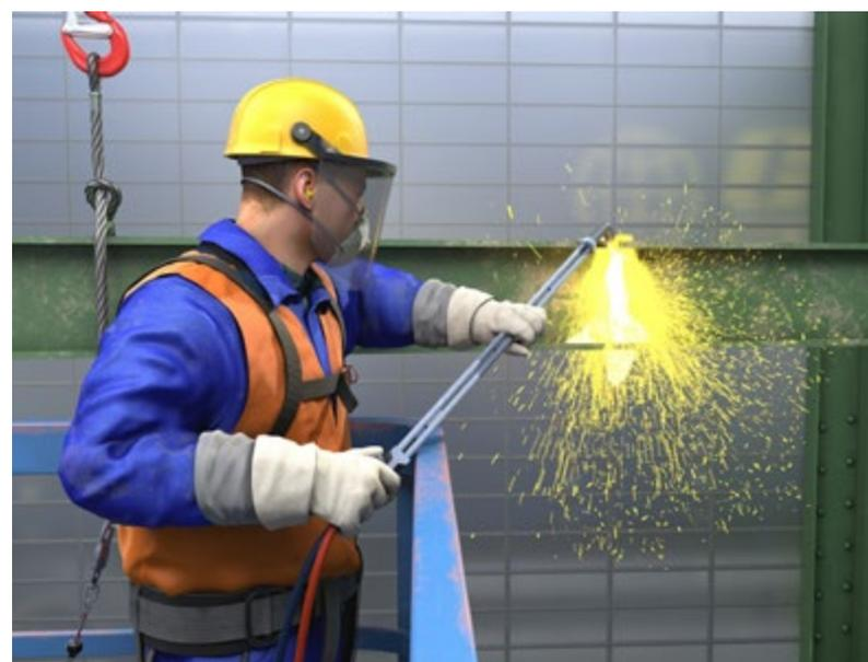
Abb. 56 Persönliche Schutzausrüstungen beim Brennschneiden
