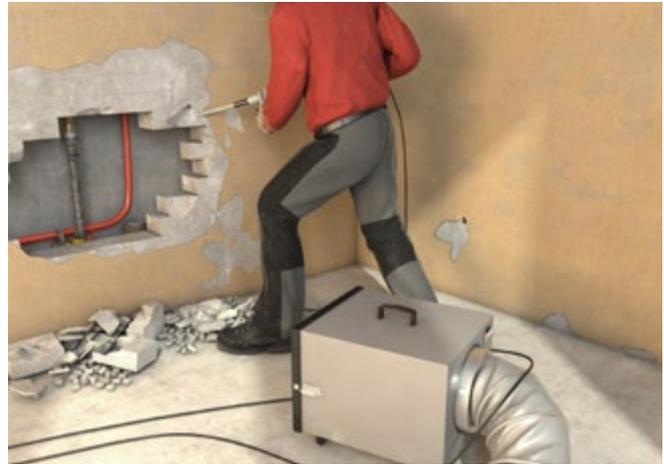
Abb. 12 Luftreiniger bei Stemmarbeiten
