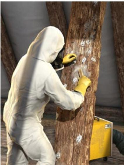
Abb. 13 Sanierung eines holzschutzmittelbelasteten Dachstuhl
