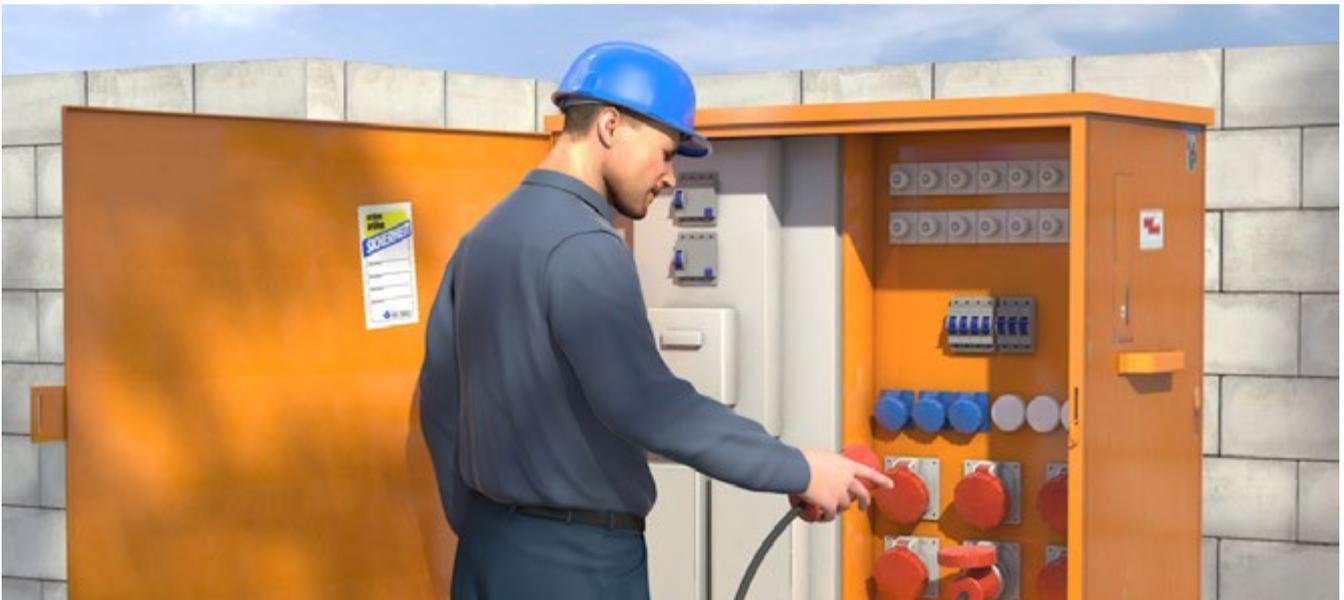
Abb. 20 Baustromverteiler zur sicheren Stromversorgung einer Baustelle
