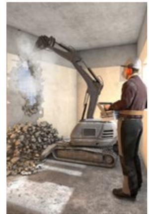
Abb. 32 ferngesteuertes Abbruchgerät
