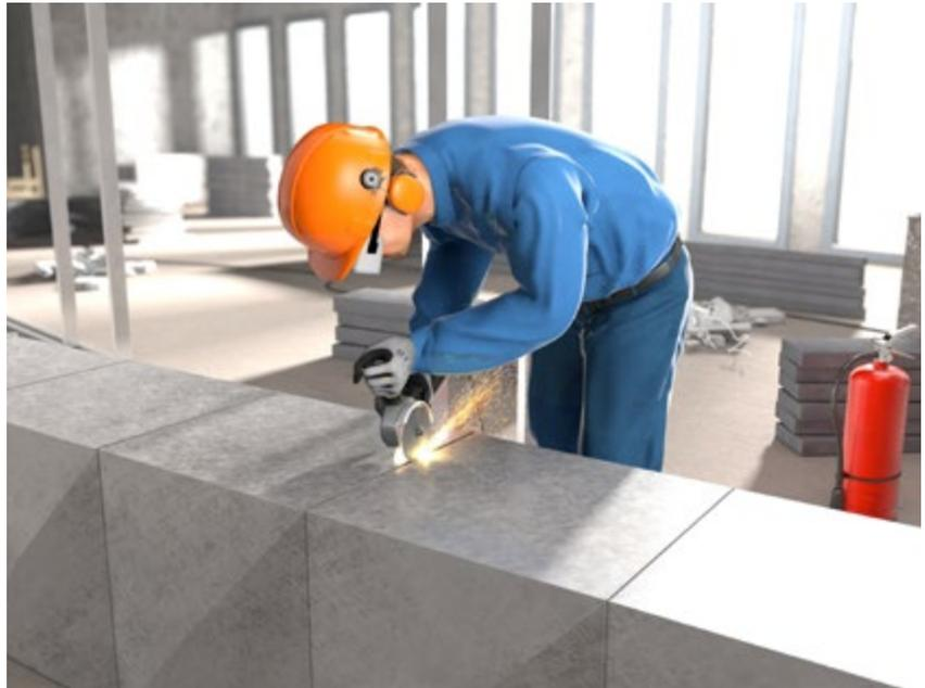
Abb 27 Persönliche Schutzausrüstung beim Trennschleifen von Metall
