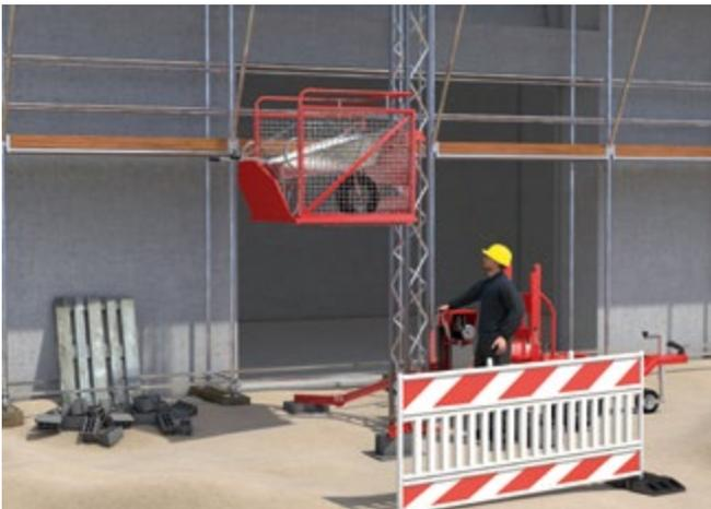
Abb. 70 Lastenaufzug
