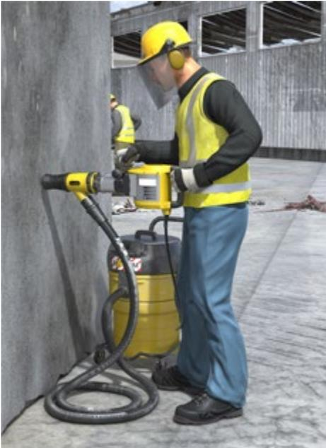
Abb 26 Persönliche Schutzausrüstung bei Arbeiten mit dem Bohrhammer
