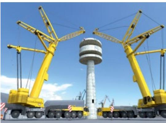
Abb. 108 Demontage eines Turms aus Stahlbeton
