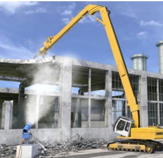
Abb. 93 Abbruchbagger mit Longfrontausrüstung
