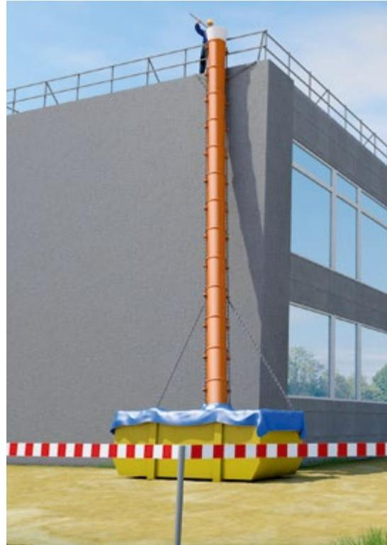
Abb. 103 Absturzsicherung an Schuttrutsche
