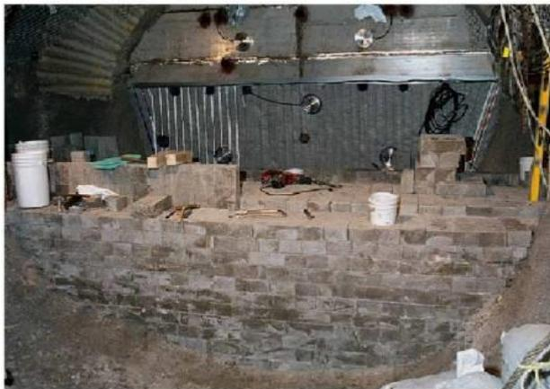
Aufgrund der fehlenden Armierung wird eine Rissbildung durch sich ausdehnende Korrosionsprodukte vermieden. Die langsame Aufsättigung des Bentonits wird zunächst durch radial zutretende Gebirgslösungen erfolgen.
