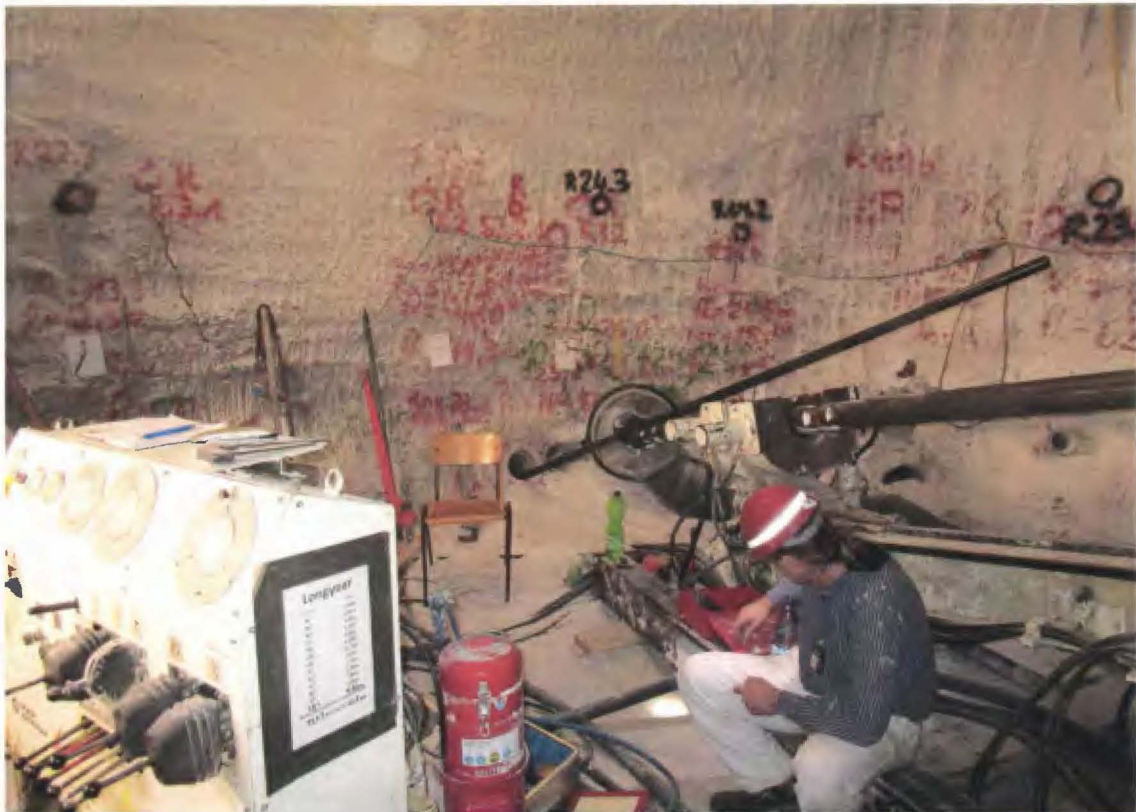
Abb. 66: Foto vom Bohrort auf der 700-m-Sohle mit Gestänge in der Verfüllbohrung BBrG. RH-725-23.2.
