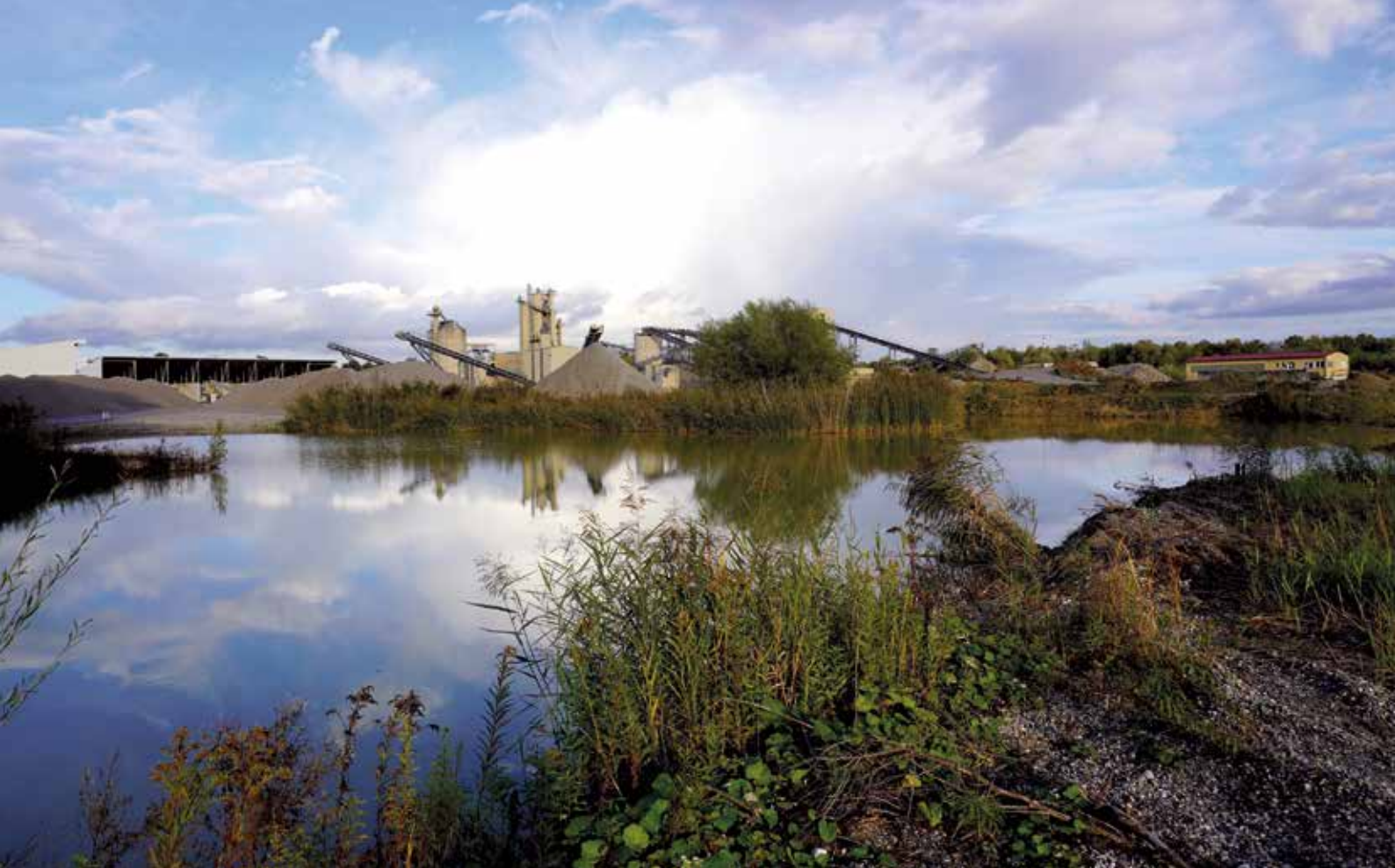
Blick auf das KW Haidhäuser der Meier Baugruppe südwestlich von Pocking, Foto: BGR.
