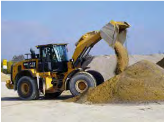
Aus einem Teil der Produktion werden im Xaver Riebel KW Allach mit Radlader Korngemische, wie 0/8 mm, 0/16 mm und 0/32 mm, hergestellt, Foto. BGR.
