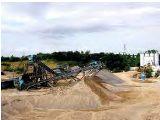
Fast die gesamte Produktionsmenge des KW Niederkassel dient zur Versorgung eines auf dem Werksgelände produzierenden Transportbetonwerks, Foto: BGR.
