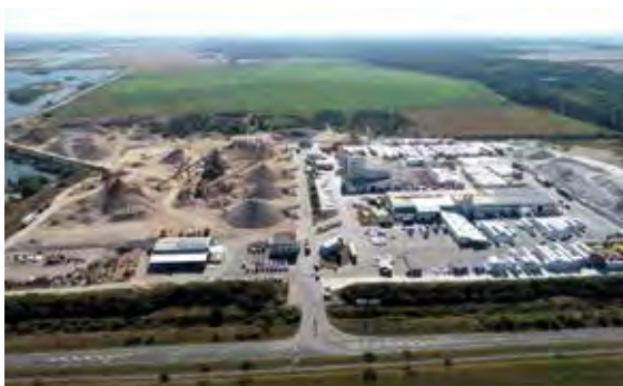
Blick über die Kieswerke Löbnitz mit Baggerseen, links, und Baustoffwerke Löbnitz, rechts, Foto: Kieswerk Löbnitz GmbH & Co. KG (mit frdl. Genehmigung).
