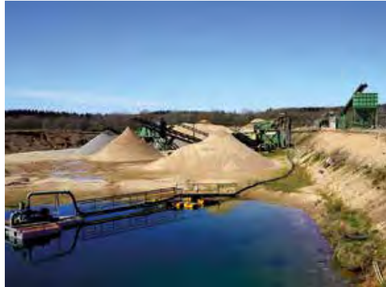
Das KW Blunk der Eggers-Gruppe dient vornehmlich der Versorgung der unternehmenseigenen Tiefbausparte mit Baustoffen, Foto: BGR.
