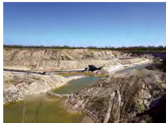
In der Sandgrube Reinbek wird der mit Radlader abgebaute Rohsand über ein Förderband in das zu versorgende Kalksandsteinwerk transportiert und die bereits abgebauten Grubenareale bald wieder mit unbelastetem Bodenaushub verfüllt, Foto: BGR.
