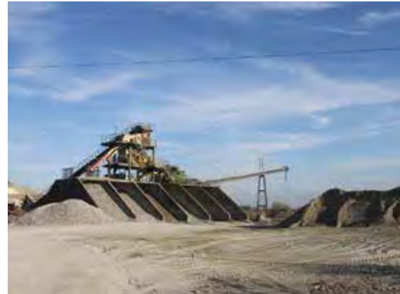
Aus dem KW Neuburg-Zell werden ausschließlich Kunden aus der Region Neuburg an der Donau versorgt, Foto: Franz Schimmer GmbH (mit frdl. Genehmigung).
