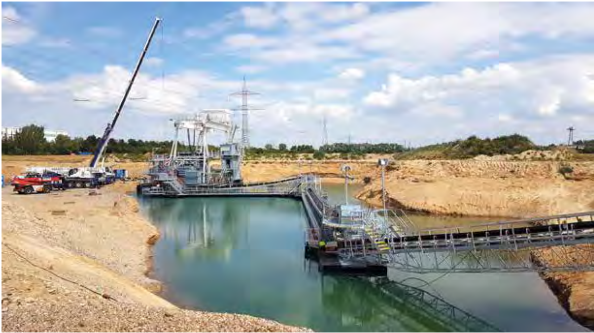
Montage des neuen, rund 4,0 Mio. € teuren Schwimmgreifers im Abbaufeld Röderau des Holcim Kieswerk Zeithain im Jahr 2020, Foto: Holcim Kieswerk Zeithain KG (mit frdl. Genehmigung).
