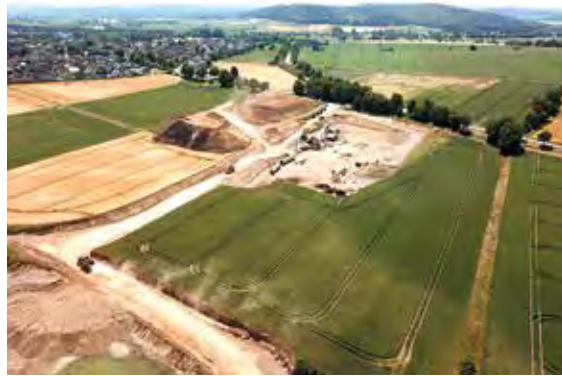
Im Frühjahr 2022 haben die Vorbereitungen zu Errichtung eines ersten kleinen Kieswerks zur Aufbereitung von Kiessanden aus dem Abbaufeld Ohr-1 begonnen, Foto: Mineral Baustoff GmbH (mit frdl. Genehmigung).
