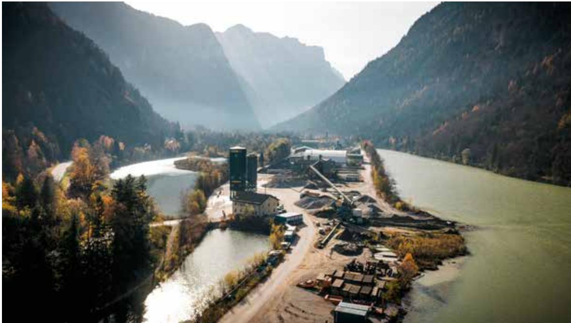
Das KW Saalachkies liegt idyllisch am gleichnamigen Stausee und wird aus dem Stausee durch einen Schrapper sowie durch Hangschuttmateriale nachhaltig mit Rohstoffen versorgt, Foto: Antretter GmbH & Co. KG (mit frdl. Genehmigung).
