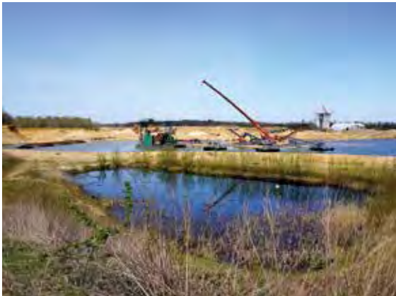
Im KW Nützen der Ernst Krebs GmbH & Co. KG war im Sommer 2022 ein Neubau des schwimmenden Förderbandes vom Schwimmgreifer notwendig. Im Vordergrund ein bereits angelegtes Biotop für Amphibien und Libellen, Foto: BGR.
