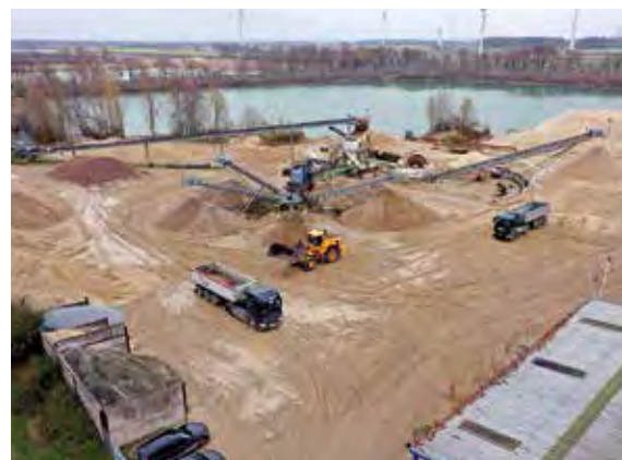
Luftbild der Aufbereitungsanlage des KW Uetze östlich von Hannover, Foto: Holcim Kies und Splitt GmbH (mit frdl. Genehmigung).
