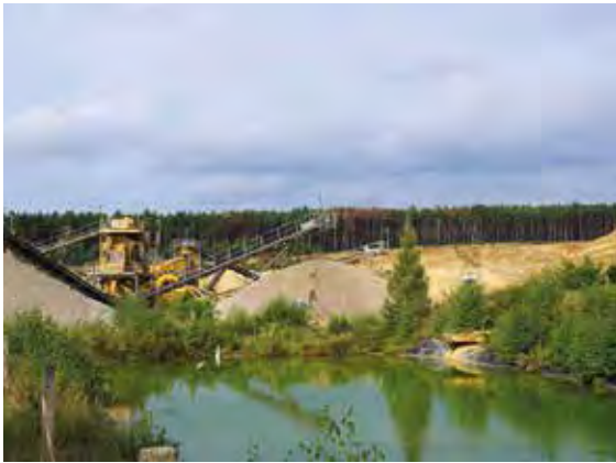
Das KW Strauch der SKR Sand-Kies-Recycling GmbH bei Großenhain bereitet Schmelzwasserkies-sande der Saale-Eiszeit zu hochwertigen Gesteinskörnungen auf, Foto: BGR.
