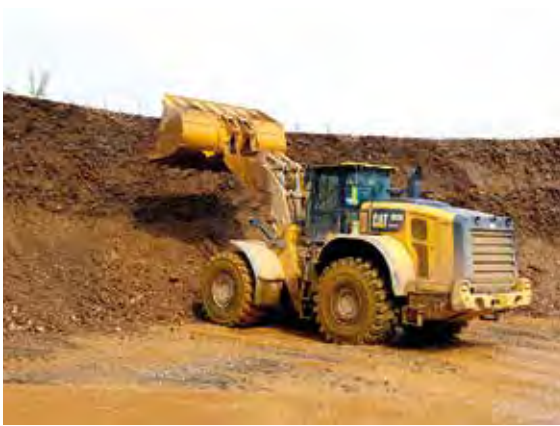
Im KW Aue der Gebr. Gropengießler GmbH werden die Flussschotter der Oderaue mittels Radlader aus der Wand gewonnen und dann über ein derzeit 2.450 m langes Förderband in die Aufbereitungsanlage transportiert, Foto: BGR.
