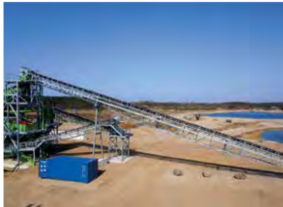
In Zurow hat die Heidelberger Sand und Kies GmbH ein modernes neues Kieswerk errichtet, das auch zukünftig die Versorgung der Stammkunden aus der Betonindustrie mit hochwertigen Gesteinskörnungen sicherstellen soll, Foto: BGR.
