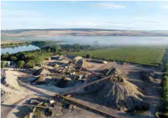
Im Unstrut-Kieswerk Oldisleben werden hochwertige Gesteinskörnungen produziert, die aber zumindest in der näheren Umgebung kaum Abnehmer finden, Foto: Mitteldeutsche Baustoffe GmbH (mit frdl. Genehmigung).
