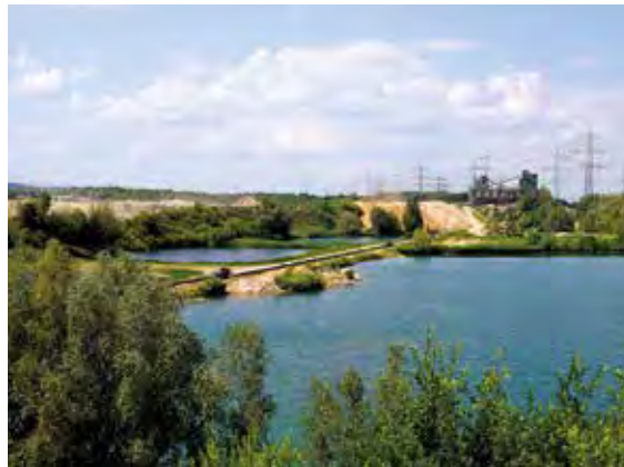
Das derzeitige, mit einem Schürfkübelbagger im Lohnbetrieb ausgekieste Abbaufeld auf dem Stadtgebiet von Brühl ist über ein 1,8 km langes Förderband mit der im Jahr 1978 eröffneten Aufbereitungsanlage in Wesseling-Berzdorf angeschlossen. Dazwischen überwindet es Böschungen und Halbinseln, die sich ansonsten die Natur längst zurückeroberet hat, Foto: BGR.
