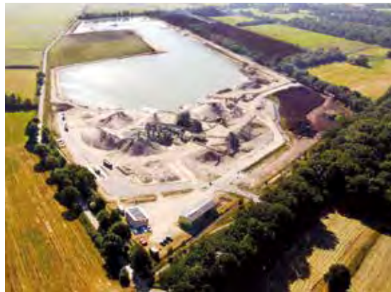
Luftaufnahme des KW Schwegermoor mit Kieswerk links und Torfwerk rechts, Foto: HKS GmbH (mit frdl. Genehmigung).
