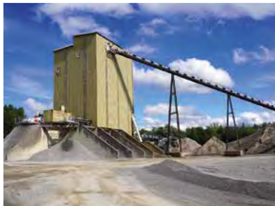
Im KW Grenis kann ohne neuen Gewinnungsstandort nur noch bis Ende 2030 Kies und Splitt für mehrere wichtige Verbraucher, darunter ein großes Asphaltmischwerk auf dem Werksgelände, produziert werden, Foto: BGR.
