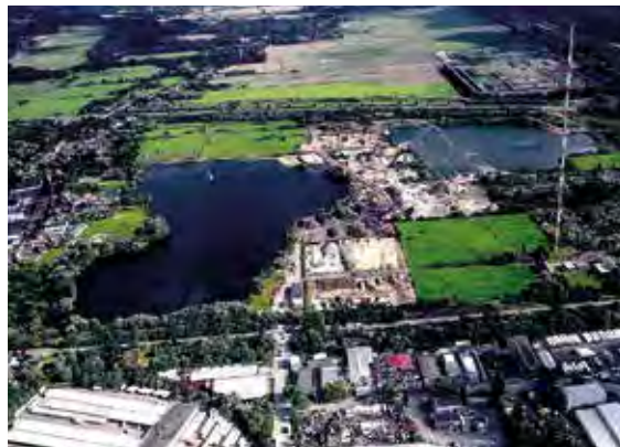
Luftaufnahme des KW Hamburg-Billbrook, Foto: RBS Firmengruppe (mit frdl. Genehmigung).
