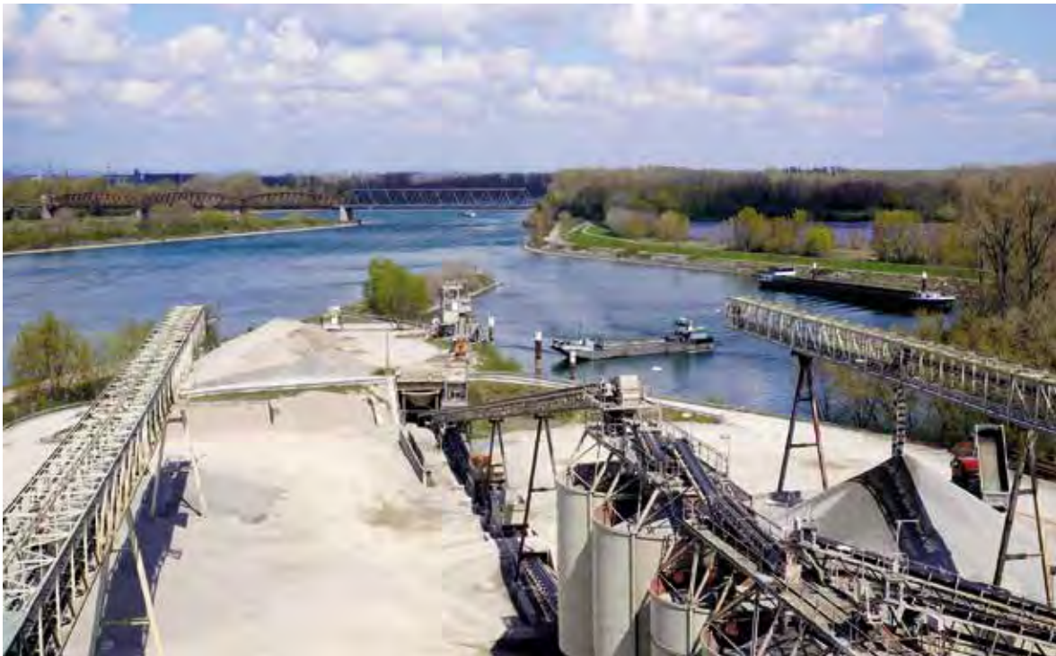
Eine Schute des Wasserstraßen- und Schiffsamtes Freiburg dockt täglich viele Male, je nach Hochwasserlage, an der Schiffsverladung des KW Iffezheim an, um nach Beladung mit jeweils 265 t Kiessand 0/63 mm dieses Material unweit nördlich im Rhein als „Geschiebezugabe“ zur Flussbettregulierung wieder zu versenken, Foto: BGR.
