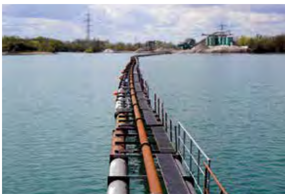
Vom automatisierten Saugschiff wird der Kiessand durch eine Pipeline zur hochmodernen Aufbereitungsanlage des KW Groß-Rohrheim der Alois Omlor GmbH gepumpt, Foto: BGR.
