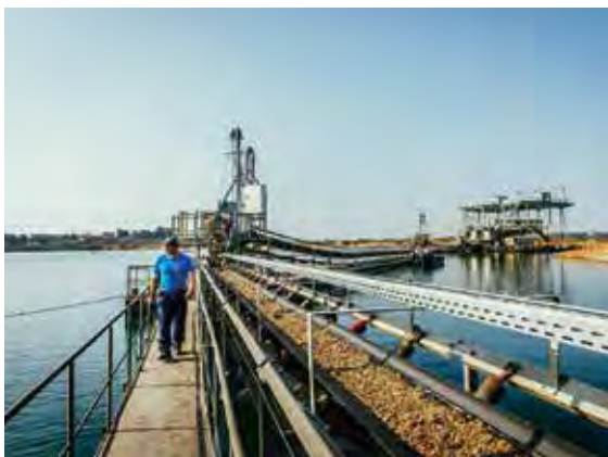
Am linkselbischen Standort Liebersee wird seit 30 Jahren hochwertiger Kiessand durch Schwimmgreifer gefördert, Foto: Hülskens Liebersee GmbH & Co. KG (mit frdl. Genehmigung).
