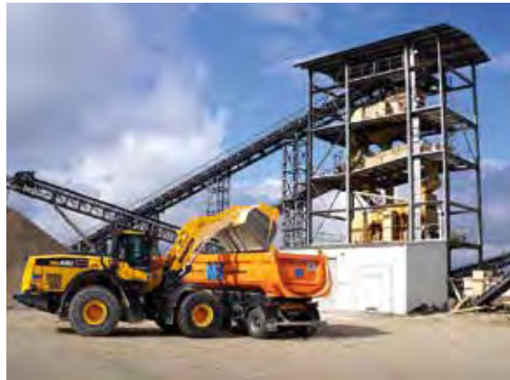
In Deggendorf-Stauffendorf betreibt die Michael Hacker Kies- und Betonwerk GmbH & Co. KG ein Kieswerk, aus dem nicht nur die eigenen Transportbetonbeteiligungen mit hochwertigen Betonkiesen und -sanden versorgt werden, Foto: BGR.
