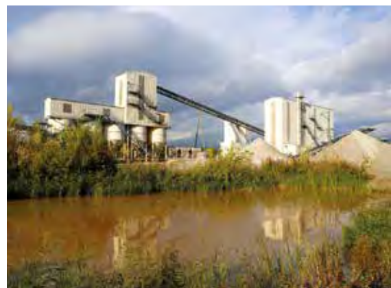
Im KW Schlupfing bei Pocking in Niederbayern werden würmeiszeitliche Kiessande des Inn verarbeitet und mit den hergestellten Gesteinskörnungen direkt ein Transportbetonwerk versorgt, Foto: BGR.
