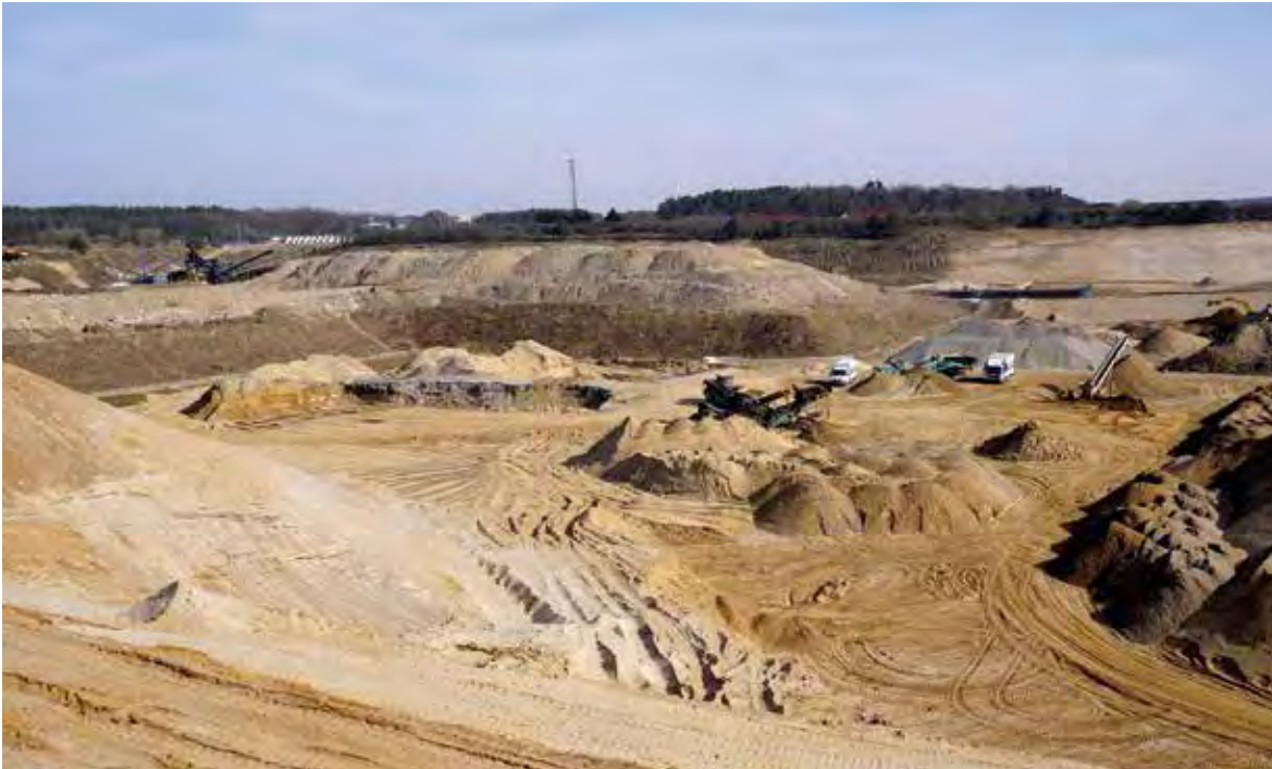
Am Standort Consrade wird nicht nur im Trockenem Kiessand abgebaut, sondern zudem in großem Umfang Bauschutt recycelt, Boden aufbereitet und auch deponiert, Foto: BGR.
