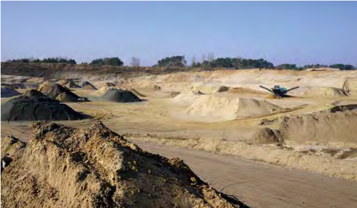
Bei Pudagla auf Usedom sind die vor rund 17.000 Jahren abgelagerten Kiessande relativ körnungsarm, so dass zur Herstellung von Mineralgemischen große Mengen an Hartgesteinssplitten zugekauft werden müssen (links im Bild), Foto: BGR.
