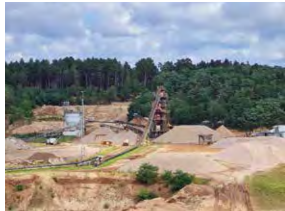
Aus dem KW Guben-Schlagsdorf wird ein Großteil des östlichen Brandenburgs mit hochwertigen Gesteinskörnungen versorgt, Foto: SCHWENK Sand & Kies Nord GmbH & Co. KG (mit frdl. Genehmigung).
