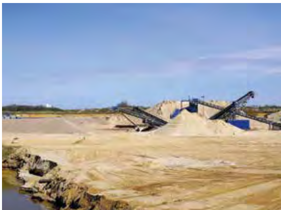
Im KW Nützen der Otto Dörner Kies und Deponien GmbH & Co. KG werden einerseits Korngemische für den Tief- und Straßenbau, andererseits Gesteinskörnungen für Betonwerke hergestellt, Foto: BGR.
