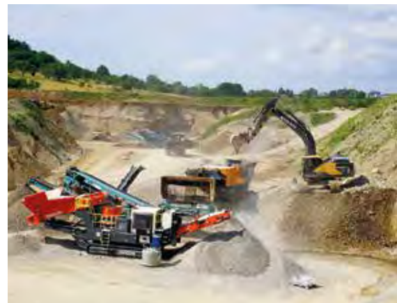
Im KW Engen-Anselfingen der Kohler Kieswerk GmbH sind zum Brechen des Überkorns und des Grobkieses verschiedene mobile Brecher im Einsatz, Foto: BGR.
