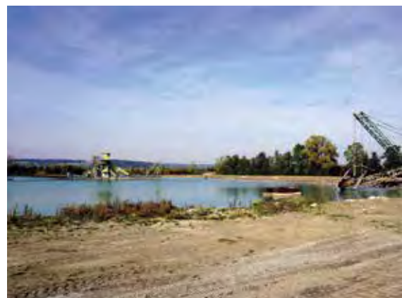
Im KW Asbach-Bäumenheim wird der Abraum mittels landgestütztem Eimerkettenbagger (Vordergrund), der Kiessand jedoch mittels schwimmendem Eimerkettenbagger (Hintergrund) gewonnen, Foto: BGR.
