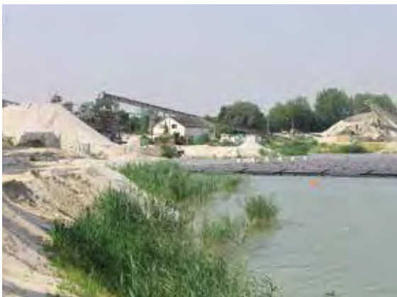
Das KW Nobitz produziert nicht nur hochwertige Baukiese und -sande, sondern auch Quarzkiese und -sande und zudem reichlich grünen Strom aus insgesamt vier Photovoltaikanlagen, davon eine schwimmende auf dem Baggersee, Foto: HEIM Kieswerk Nobitz GmbH & Co. KG (mit frdl. Genehmigung).
