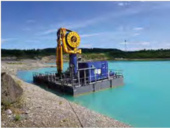
Zur Durchtrennung von unterhalb des Grundwasserspiegels anstehenden mächtigen Grundmoränenbänken hat das Unternehmen Meichle + Mohr extra eine Unterwasserfräse gekauft, Foto: BGR.
