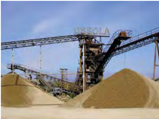
Im Kieswerk Ossola werden elf verschiedene Sorten an Sanden, Kiesen und Splitten produziert, Foto: BGR.
