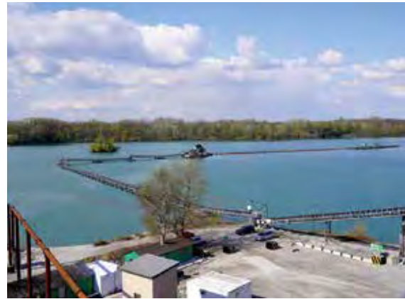
Blick vom höchsten Punkt des KW Liedolsheim der Heidelberger Sand und Kies GmbH auf den Baggersee; hinter dem Auewald im Hintergrund verläuft der Rhein. Die Gewinnung erfolgt mittels Saugschiff mit Vortrocknung des geförderten Rohkiessandes in einem schwimmenden Schöpfrad, Foto: BGR.
