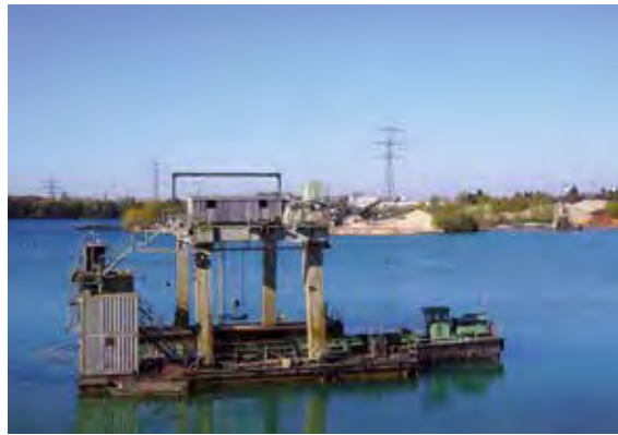
Blick auf den Baggersee der Fa. EKS Eugen Kühl und Söhne GmbH & Co. KG von Nordosten mit Schwammgreifer im Vordergrund, Elevierbagger im Hintergrund rechts und Kieswerk im Hintergrund Mitte, Foto: BGR.
