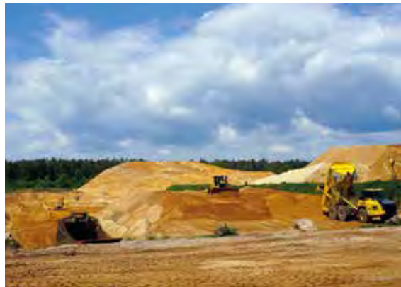
Nordwestlich Babenhausen bereitet die Schumann & Hardt GmbH & Co. KG für ihr neues KW Akazienhof die Anlage eines völlig neuen Baggersees vor. Hierfür muss jedoch vor Aufbau der Schwimmgreiferanlage zuerst einmal der Grundwasserspiegel erreicht werden, Foto: BGR.
