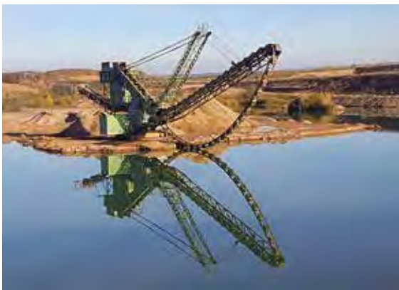
Im KW Arnstadt ist ein landgestützter Eimerkettenbagger zur Gewinnung der Kiessande unterhalb des Grundwasserspiegels im Einsatz, Foto: Märker Kies GmbH (mit frdl. Genehmigung).
