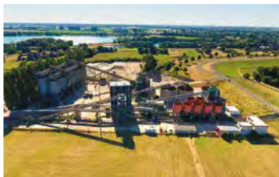
Das KW Ellerdonk nördlich Wesel ist eines der produktionsstärksten in Nordrhein-Westfalen, Foto: George Sommer/Holemans GmbH (mit frdl. Genehmigung).
