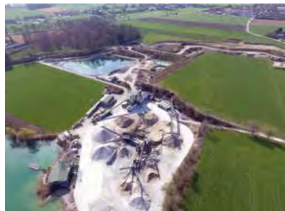
Luftbild des KW Ainring mit altem Baggersee und Aufbereitungsanlage im Vordergrund, aktueller Nassauskiesung in der Bildmitte und länglicher Trockenkiesgrube im Hintergrund, Foto: Kieswerk Brötzner GmbH & Co. KG (mit frdl. Genehmigung).
