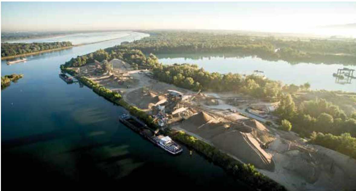
Luftaufnahme des KW Meißenheim mit Schiffsverladung im Vordergrund und KW Neuried-Ichenheim mit Schiffsverladung im Hintergrund, Foto: Heinz Schlecht, RMKS RHEIN MAIN KIES UND SPLITT GmbH & Co. KG (mit frdl. Genehmigung).
