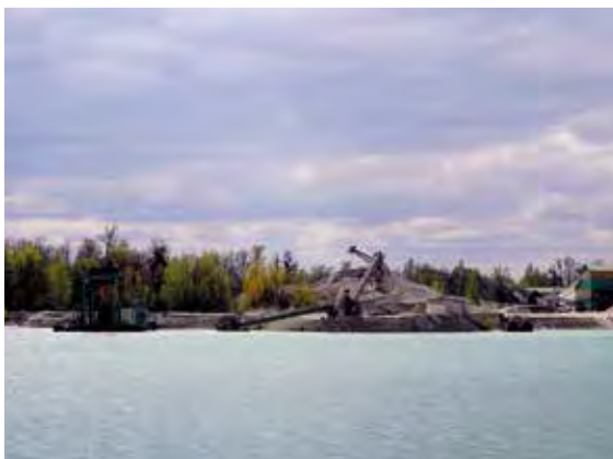
Blick von der Schiffsverladung am Steingrundsee auf das am Südende des Sees gelegene KW Rheinau-Freistett der Hermann Peter KG. Im Vordergrund der Elevierbagger, dieser wird über Klappschuten vom Schwimmgreifer am Nordende des Baggersees mit Rohkies versorgt, Foto: BGR.
