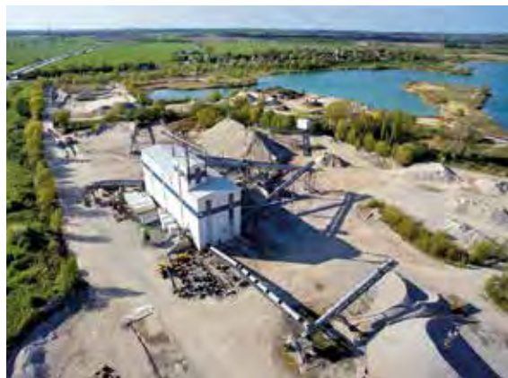
Blick über das KW Leipzig-Hirschfeld mit der A14 im linken Hintergrund, Foto: Schotter- und Kies-Union GmbH & Co. KG (SKU) (mit frdl. Genehmigung).
