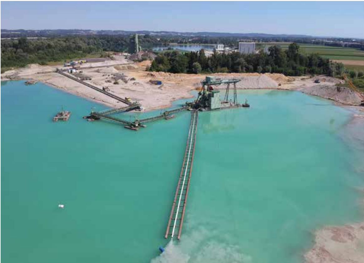
Im KW Moosburg ist ein großer Schwimmgreifer in der Auskiesung tätig, mit dem jedoch nur die obersten Meter des wesentlich mächtigeren Kiessandhorizontes abgebaut werden dürfen, Foto: Rohrdorfer Gruppe (mit frdl. Genehmigung).
