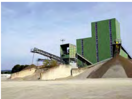
Das moderne und zum Lärm- und Frostschutz vollständig eingehauste KW Schäfstall der Wanner & Märker GmbH & Co. KG nimmt wichtige Versorgungsaufgaben im mittleren Donaunraum wahr, Foto: BGR.
