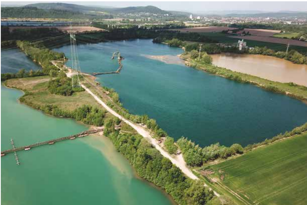
Zwischen Tündern und Hameln wird bereits seit den 1950er Jahren Kies der Weser-Niederterrasse abgebaut, Foto: Mineral Baustoff GmbH (mit frdl. Genehmigung).
