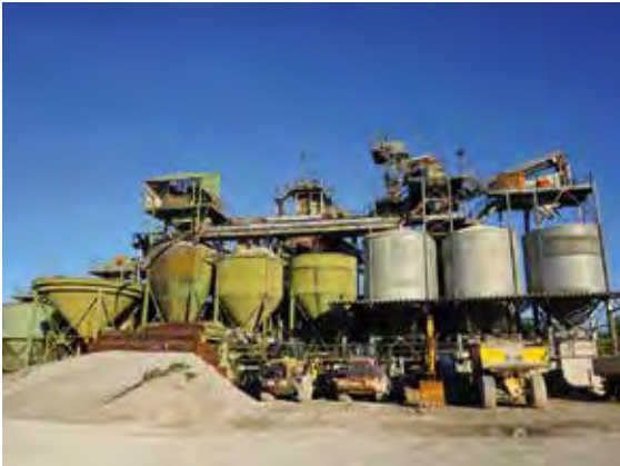
Das KW Königsdorf der Gämmerler Kieswerke Königsdorf GmbH ist seit 1965 ein zuverlässiger Lieferant von Sand und Kies im Landkreis Bad Tölz-Wolfratshausen, Foto: BGR.
