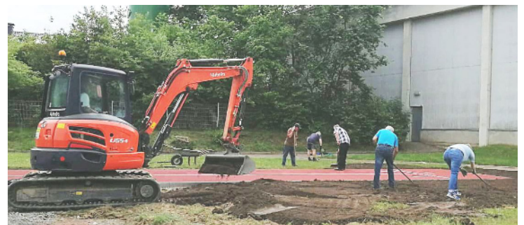
Bild unten: Armin Knüppel verteilt den Aktivboden, während die Planarbeiten direkt danach stattfanden und die Rasenfläche entsteht.
