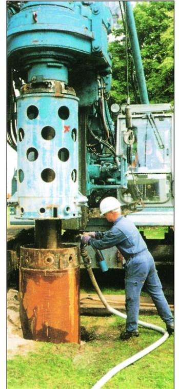
▶ Herstellung von 24 m tiefen Versickerungsbrunnen, Durchmesser 800 mm
