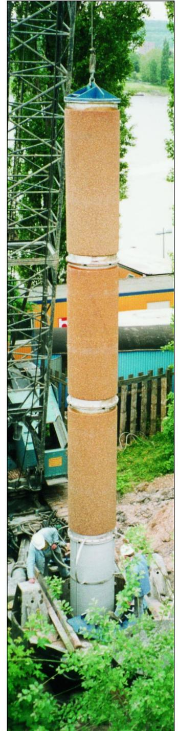
▲ *Einbau von 800 mm Ø Edelstahlfiltern mit Kiesbelag, Verrohrte Greiferbohrung, Bohrdurchmesser 1.800, Brunntiefe 25 m*
