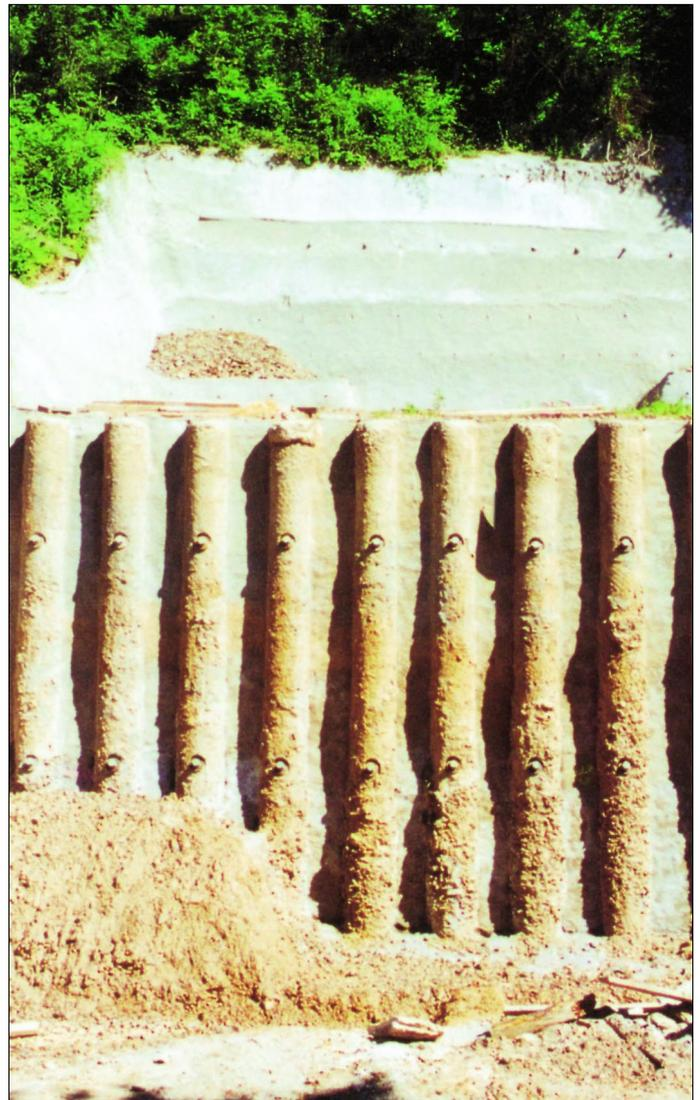
Aufgelöste Bohrpfehlwand mit Spritzbetonausfachung und Dauerverankerung sowie Spritzbetonhangsicherung ▶
