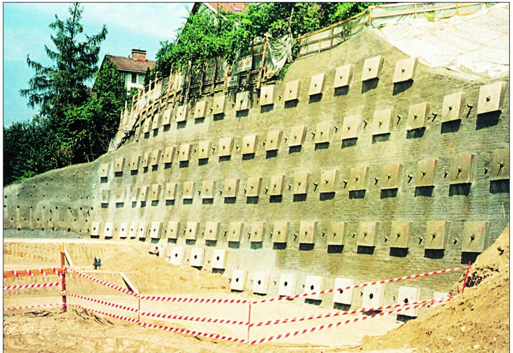
Hangsicherung durch Spritzbeton, Fertigteilplatten und Temporäranker ▶
