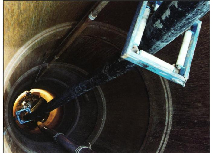
wird eine Tunnelverbindung hergestellt. Der so geschaffene Raum dient als Arbeitsraum für die notwendigen Baumaßnahmen zum Einziehen der neuen Drainagen im Berstling Verfahren.
