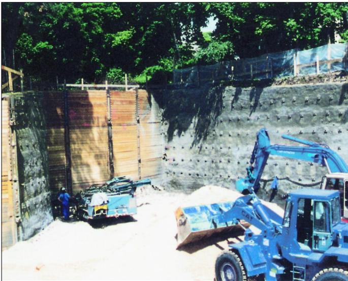
▲ Bodenvernagelung für eine 8,50 m tiefe Baugrube, nach allgemeiner bauaufsichtlicher Zulassung
