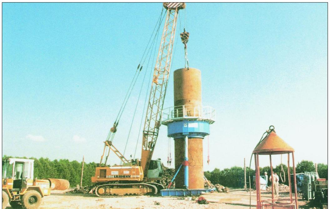
Anschließend werden PE-HD-Rohre auf der Deponiesohle verlegt, mit einer Kiesschüttung ummantelt und wieder verfüllt. Ist die Drainage eingebracht, wird der erste Schacht gezogen und hinter dem zweiten Schacht ein weiterer Schacht abgeteuft.
