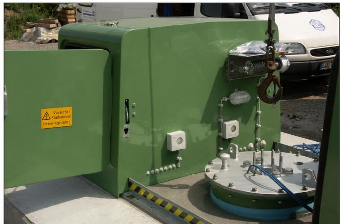
an Zeit, Material und Kosten durchzuführen wäre. Die oberirdische Brunnenstube vermeidet Risiken und Gefahren durch die Anordnung der Anlagenteile oberhalb der Erdgleiche. In allen Zonen der Trinkwasserschutzgebiete sind unsere Anlagen zugelassen und im Einsatz, mit zusätzlichen Baumaßnahmen auch in hochwassergefährdeten Gebieten.
