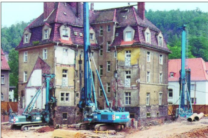
▲ Drehbohranlage beim Herstellen einer Pfahlwand
