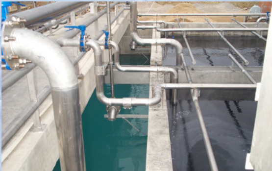
Blick auf einen HOK-Reaktor einschließlich Beschickungssystem sowie Druckluft-Rohrleitungen
