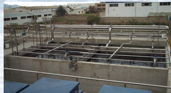
HOK-Reaktor eines Textilbetriebs in Marokko (Reduzierung der hohen CSB-Konzentrationen sowie Entfärbung des Abwassers)
