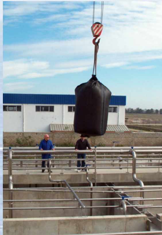
Verfüllung von HOK-Herdofenkoks mit Hilfe von Big Bags
