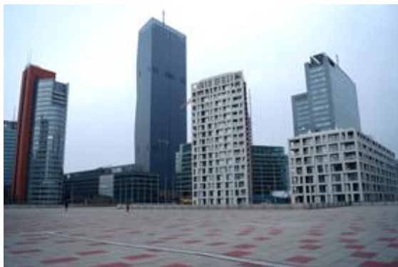
Abbildung. 11: Donau City: Andromeda Tower, DC Tower 1, DC Living, Ares Tower (von links nach rechts, Quelle: Foto Walter Matznetter 2014).
