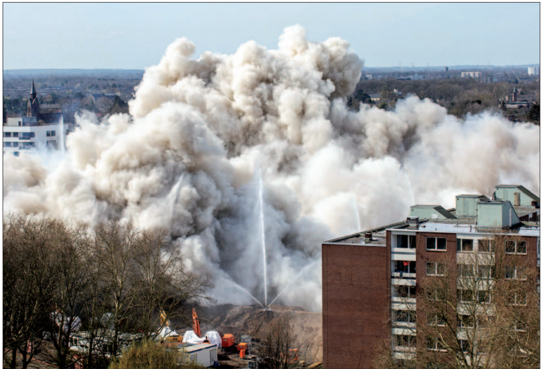
Sprengung des ersten „weißen Riesen“, eines leerstehenden Wohnkomplexes, im März 2019 in der Großstadt Duisburg in Nordrhein-Westfalen
