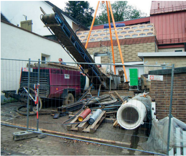
Teufgerüst zur Aufwältigung des Tagesbruches „Alter Schacht“
