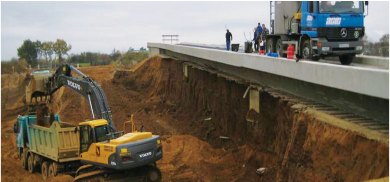
Brücken- und Erdbauarbeiten am Wirtschaftsweg Olbertzer Brücke
