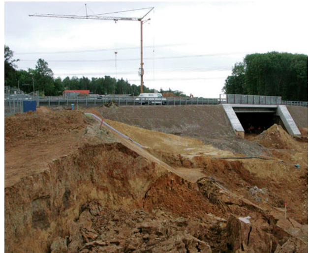
Böschungsumbildung im Bauabschnitt West
