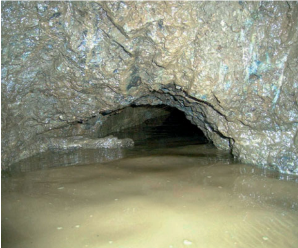
Stollen bis unter die Firste eingestaut
