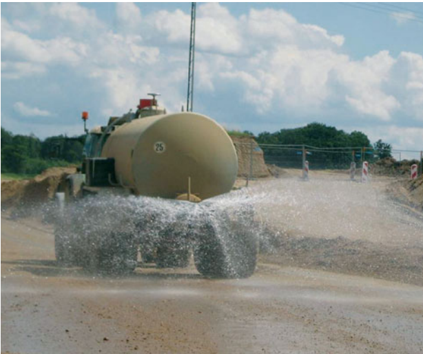
Benetzung eines unbefestigten Fahrbahnabschnittes
