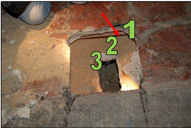
Bild 19: Aufbau einer Försterdecke, 1 Plattenbelag und Estrich, 2 Walzträger (Obergurt siehe Pfeil), 3 Steindecke, vergleiche Bild 2
