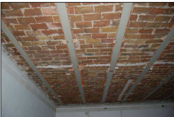
Bild 20: Untersicht einer Försterdecke
