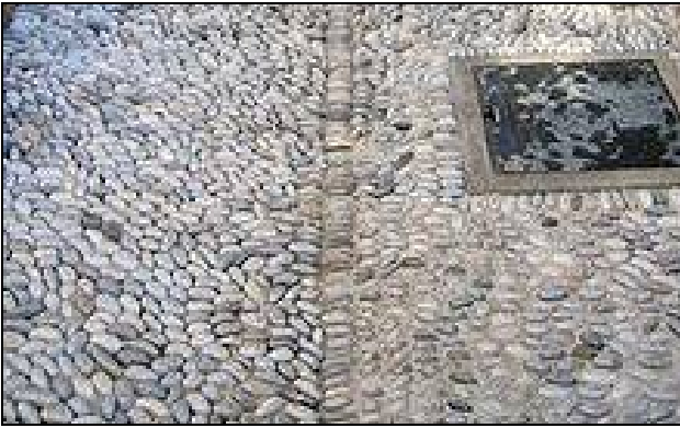
Bild 5: Beispiel eines Zierpflasters aus Lesesteinen, hier Straßenbelag mit unbekanntem Unterbau, Bildquelle Wikipedia
