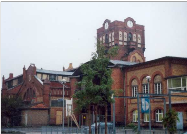
Bild 1: Schlachthof Offenbach, Baujahr 1904 Zentrale Verteilerhalle (Mitte) mit Schlachtung (Rechts), Kühlhäusern und Eisfabrik (Links) sowie Wasserturm
