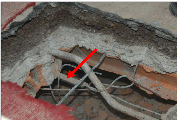
Bild 25: Im Bereich Endauflager geöffnete Kaiserdecke, Vergusskanal siehe Pfeil, vergleiche Bild 26
