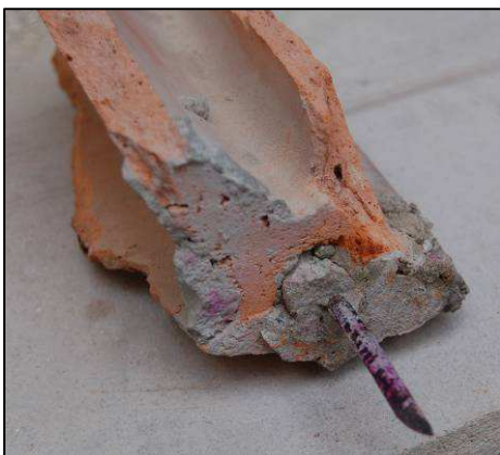
Bild 25: Vergusskanal des Systemsteins Kaiserdecke, vergleiche Bild 22 und 25
