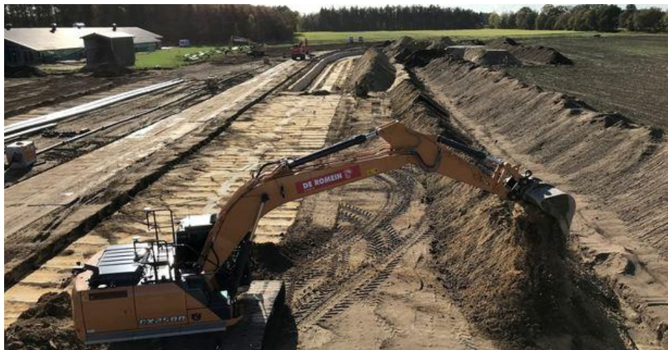
Bild C.1: Regelgrabenprofil 380-kV-Leitung Fedderwarden-Conneforde (TenneT 2016a, S. 64)
