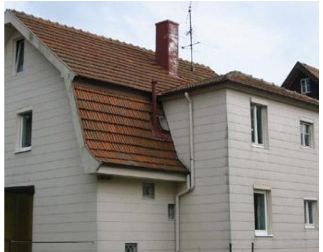
Asbesthaltige Fassadenverkleidung
