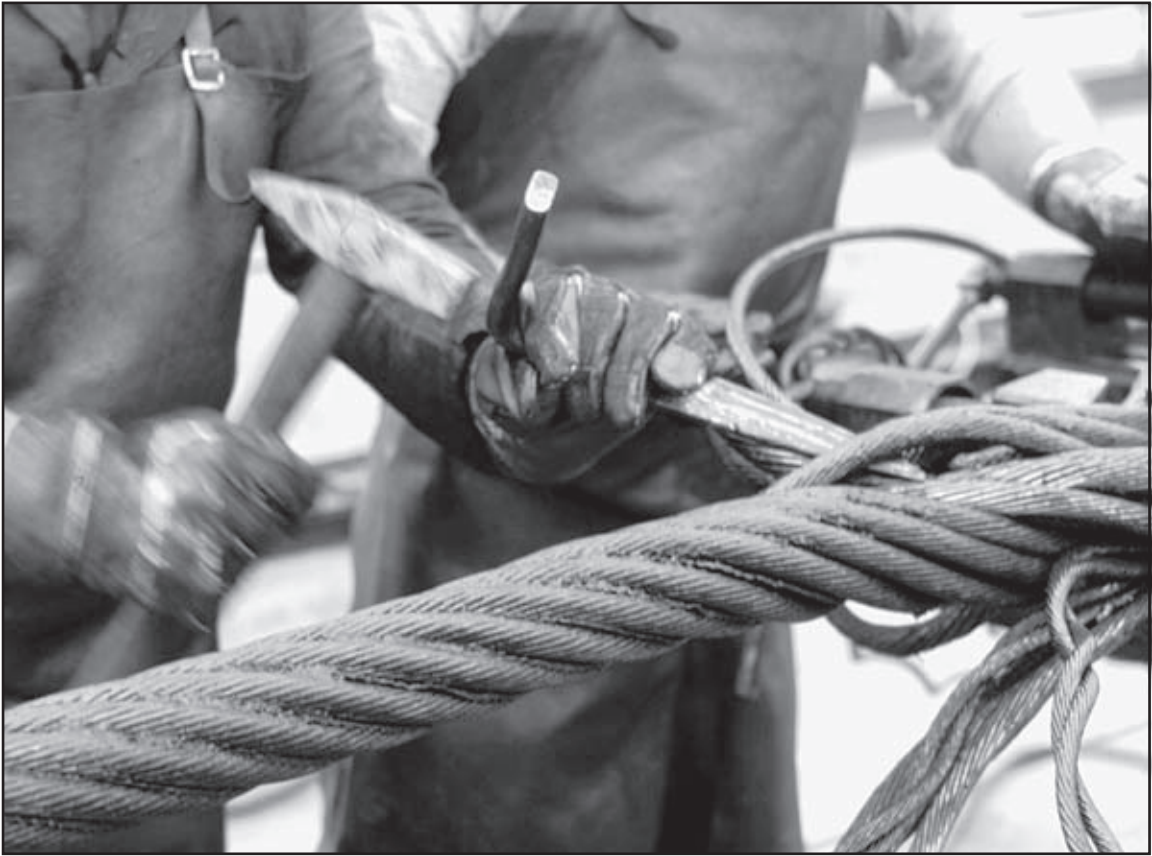
Bild 31: Einschlagen des Spleißnagels
