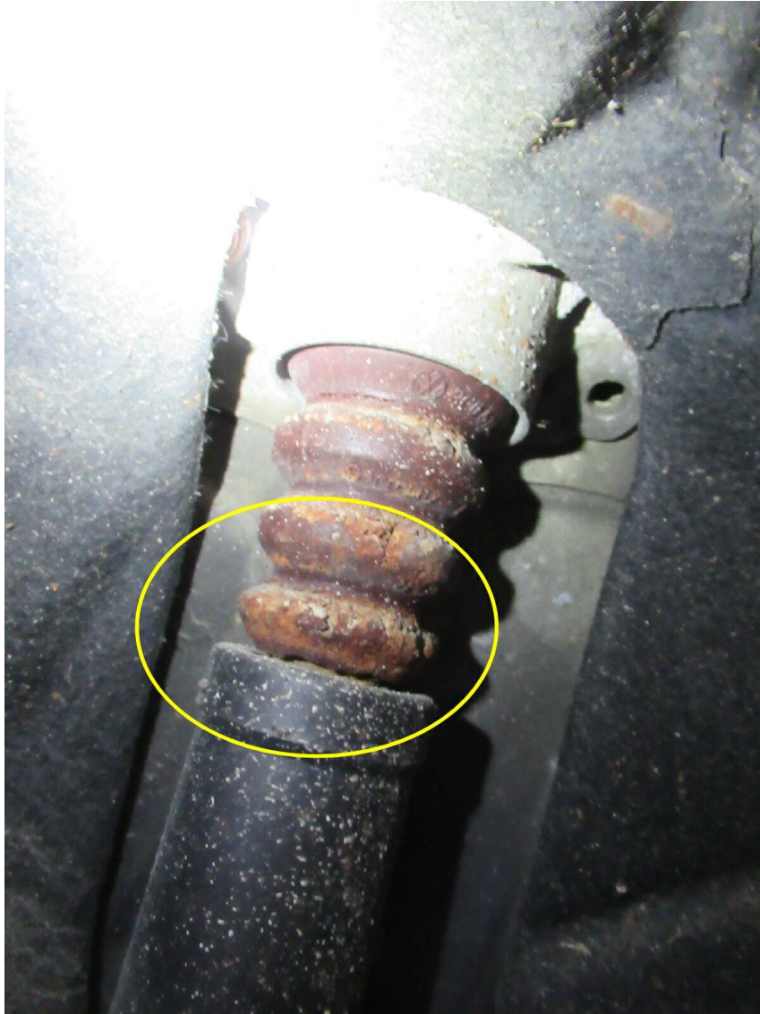
Bild 12 : Anschlagpuffer hinten eingerissen
