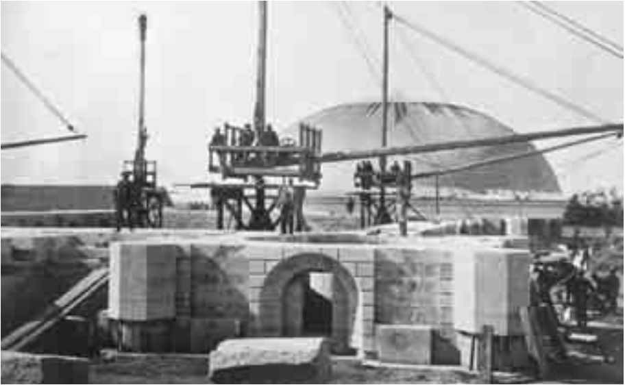
Foto von den Bauarbeiten am Salt-Lake-Tempel. Präsident Young hatte sein Leben der Aufrichtung Zions geweiht und erklärt: „Das soll unser Lebenszweck sein: Das Zion unseres Gottes aufzubauen.“ (DBY, 88.)
