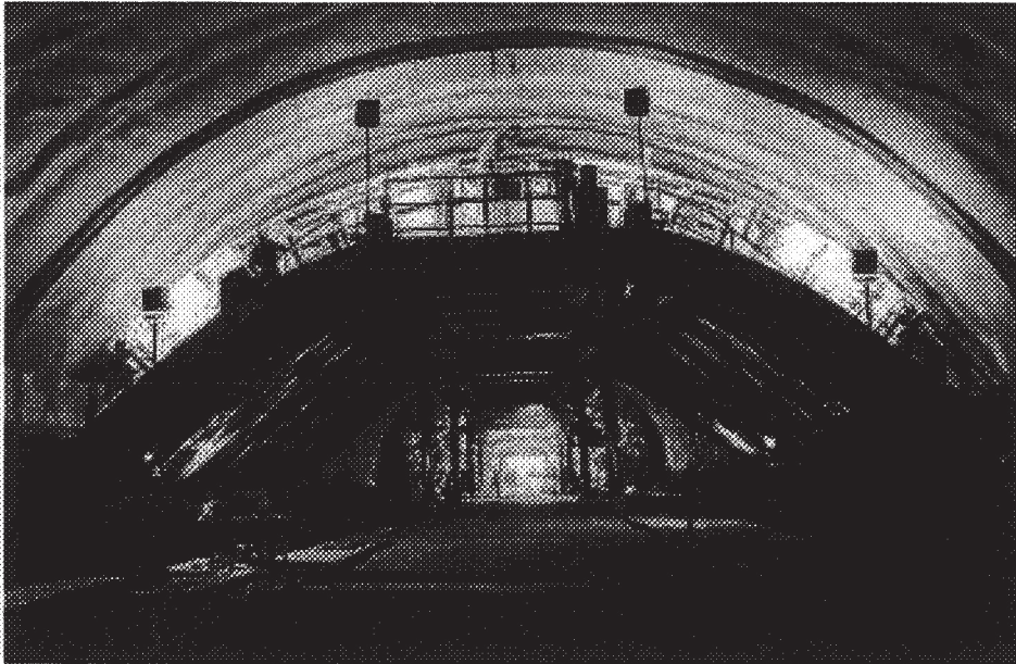
1 Gewölbeschalwagen im Engelberg-Basistunnel
