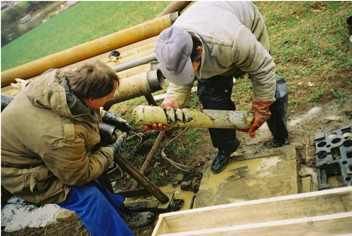
Abb.1) Harter Muschelkalk und weicher Klufflehm: Ergebnis bester Abstimmung von Kernrohr, Krone, Bohrspülung und Bohrmannschaft. Seilkernrohr SK6L 146 x 102 / Synset-Krone.A3 bei Würzburg.
