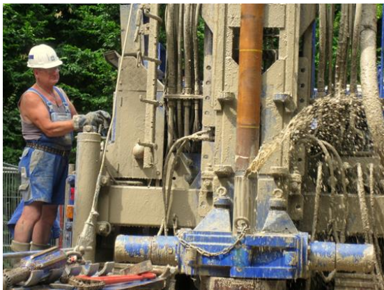
Abb. 12) Spülbohrung CSK 146 Kern 102 mm
