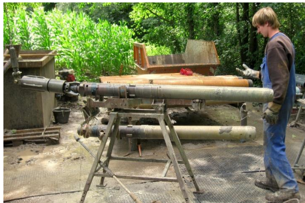
Abb. 13) Rammkernbohrung Nordmeyer System Kern 102 mm
