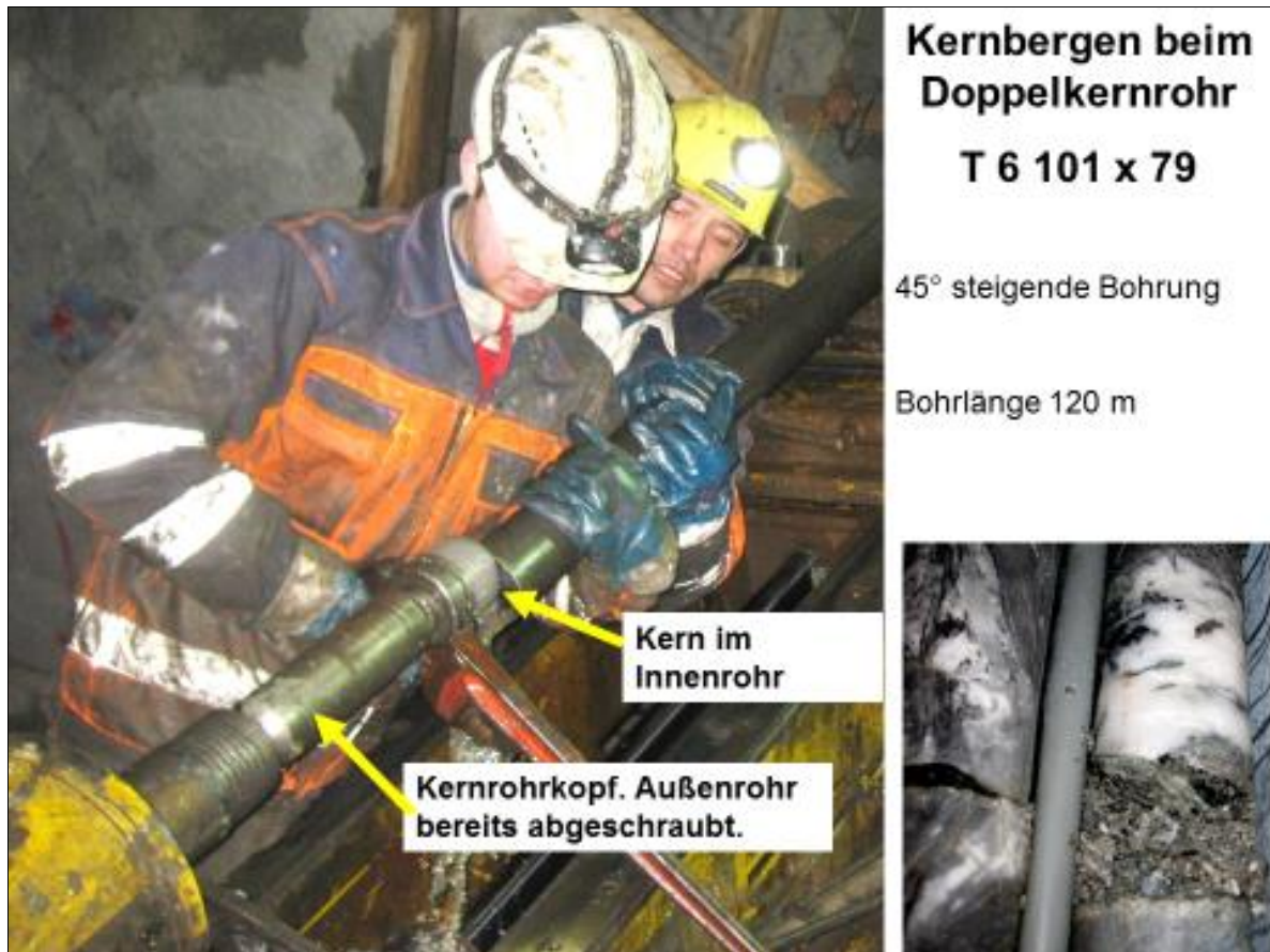
Abb. 8) Phylitische Schiefer mit Quarzgängen und Störungszone. Ein Doppelkernrohr hält Rotation und Spülung vom zu erbohrenden Kern ab. Ohne Bergung dieser weichen Formation würde eine freie Kluft vorgetäuscht. Folge wäre eine Fehleinschätzung für eine Injektionsmaßnahme mit Zementsuspension.
