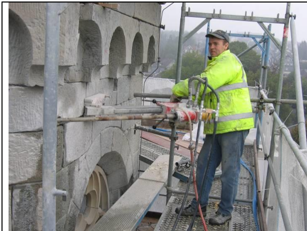
Bohren mit dem Einfachkernrohr in historischen Bauwerken.
