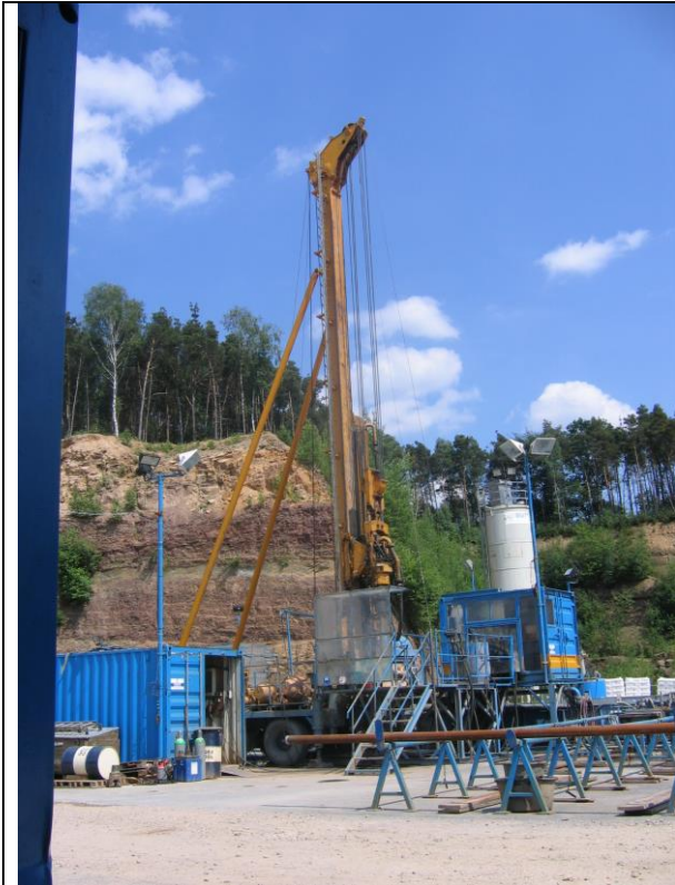
Seilkern - Tiefbohranlage für abgelenkte Bohrungen bis 2000 m Bohrlänge. DSK in Ibbenbüren.
