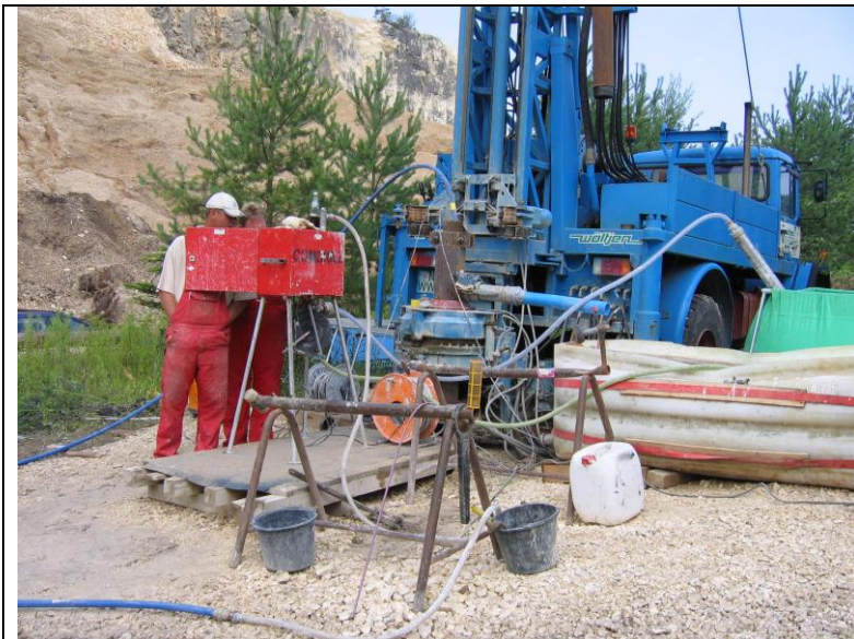
In den Bohrstrang des CSK 146 eingebauter Packer und Messgerät für Wasserdruckversuche.
