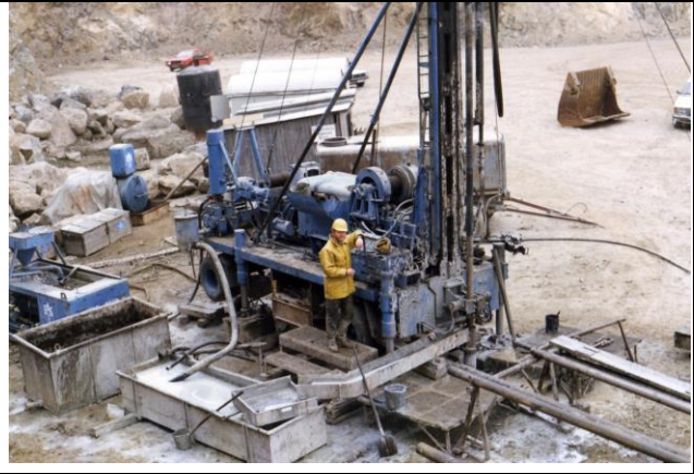
Seilkernrohr HWL im Einsatz auf einer 300 m Erkundung in der Oberpfalz .Happel, 1985
