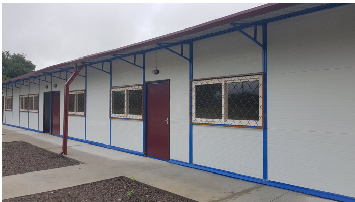
Der renovierte Klassenzimmerblock der Sonderschule in Kapani
