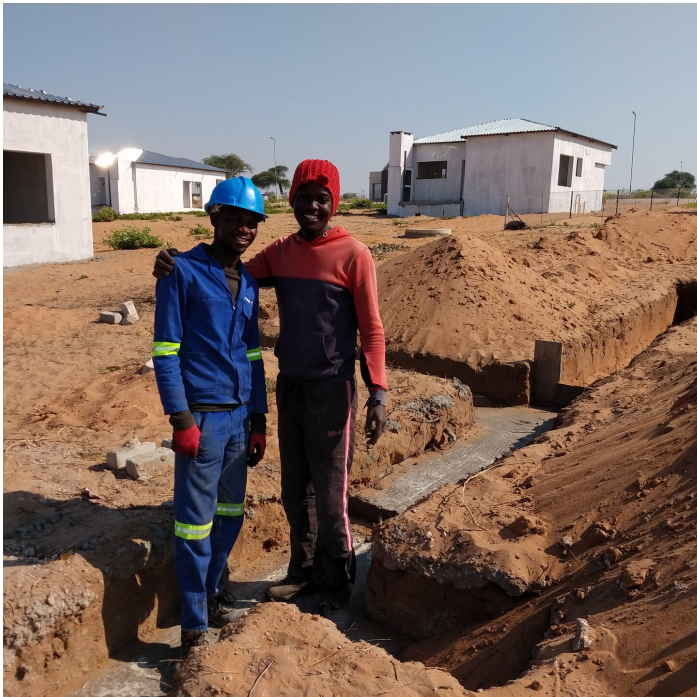
1200 Häuser werden erstellt, Praktikanten der gehörlosen Schule legen das Fundament
