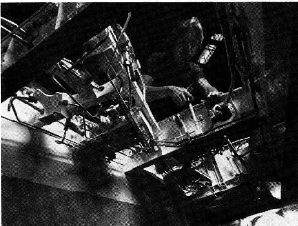
Bild 5: Installation von Shape-Memory-Rohrverbindern
