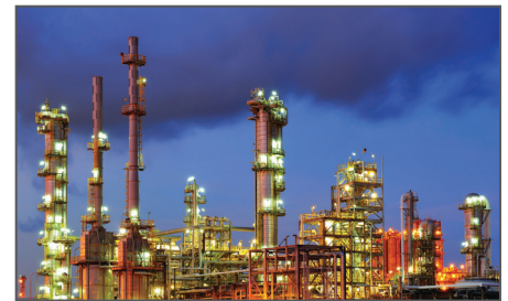
Öl und Gas, chemische und petrochemische Werke
