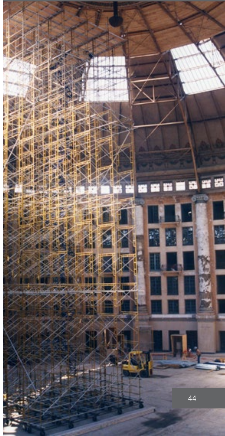
West Baden Hotel Renovierung
