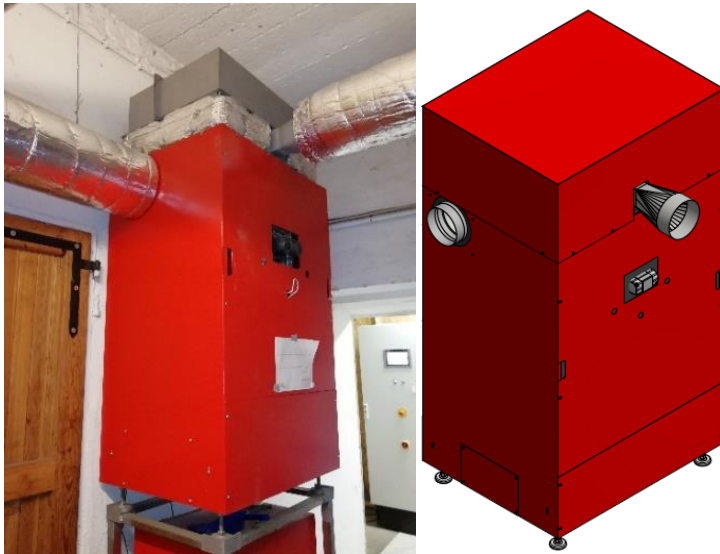
Abbildung 40: 2-Rohr-ESP im Heizraum und als 3D-Modell
