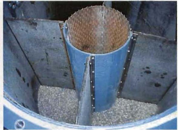
Innenansicht URSEL: 4 Quadranten, Brunnenfilterrohr zweigeteilt (PVC-Schlitzfilter & Stahl-Schlitzbrückenfilter)
