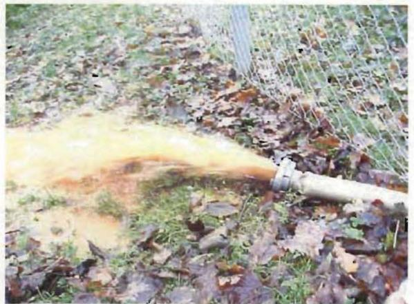
abgepumptes Wasser nach mechanischer Vorreinigung
