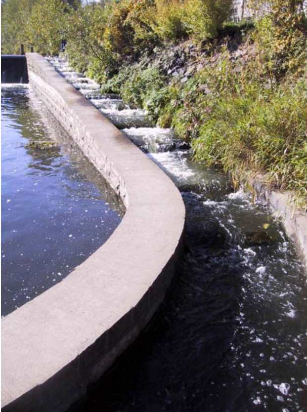
Foto 11 Gesamtansicht des Rauhgerinne-Beckenpasses in der Werra am Henneberger Wehr in Meinigen
