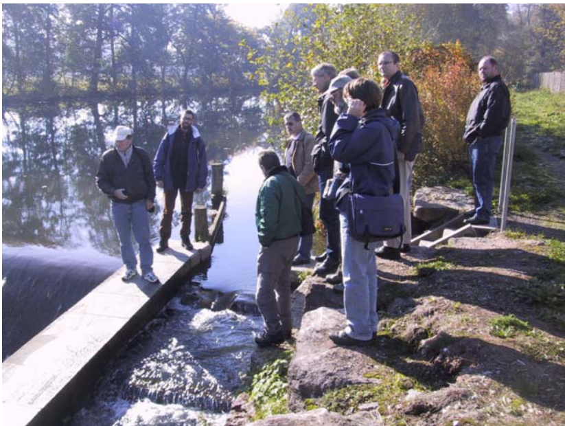
Foto 2 Besichtigung des Raugerinne-Beckenpasses am Henneberger Wehr in der Werra in Meiningen
