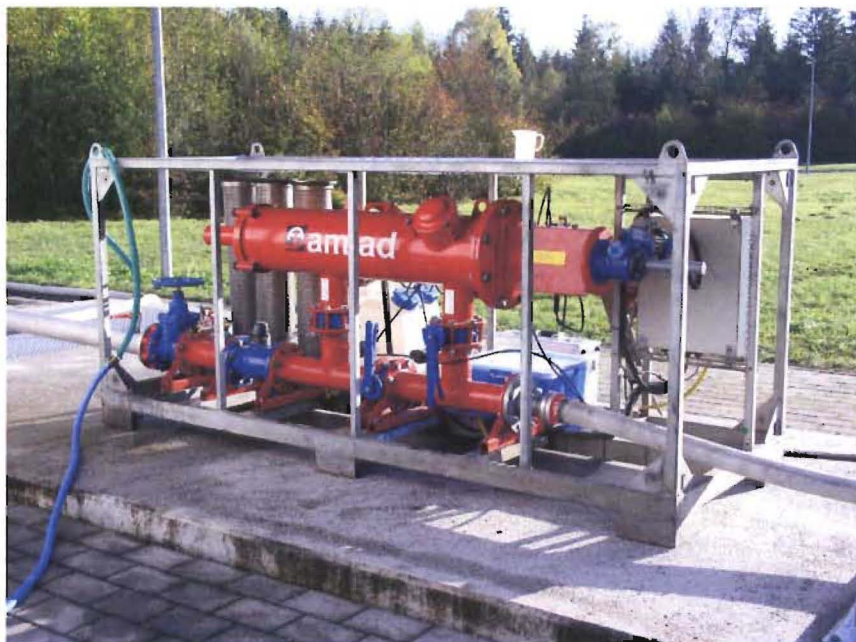
Abbildung 4-6: Amiad-Filtrationsanlage
