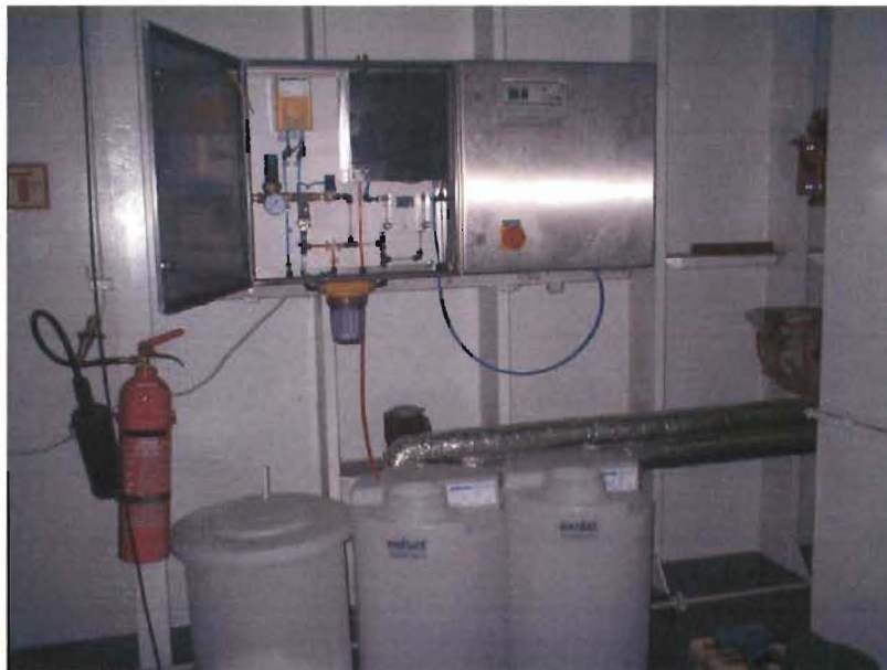
Abbildung 3-2: SINCERUS-ECA-Anlage (Diaphragmalyse)
