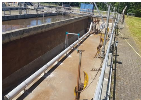
Abbildung 9: Optimierung der Leitungsführung des Rücklaufschlammes
