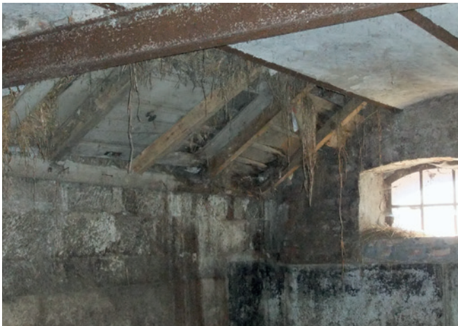
Abb. 1: Kappendecke in einem Stallgebäude.
