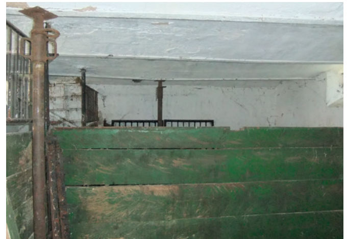
Abb. 2: Kappendecke in einem Stallgebäude (s. auch Projektbeispiel).
