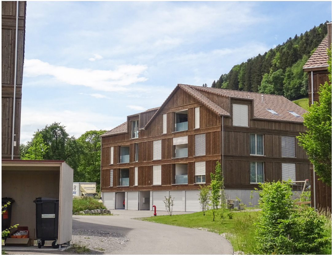
Die Zufahrten zu den Garagen prägen die Eingänge zur Siedlung. Foto: V. Härdi, Denkmalpflege AR
