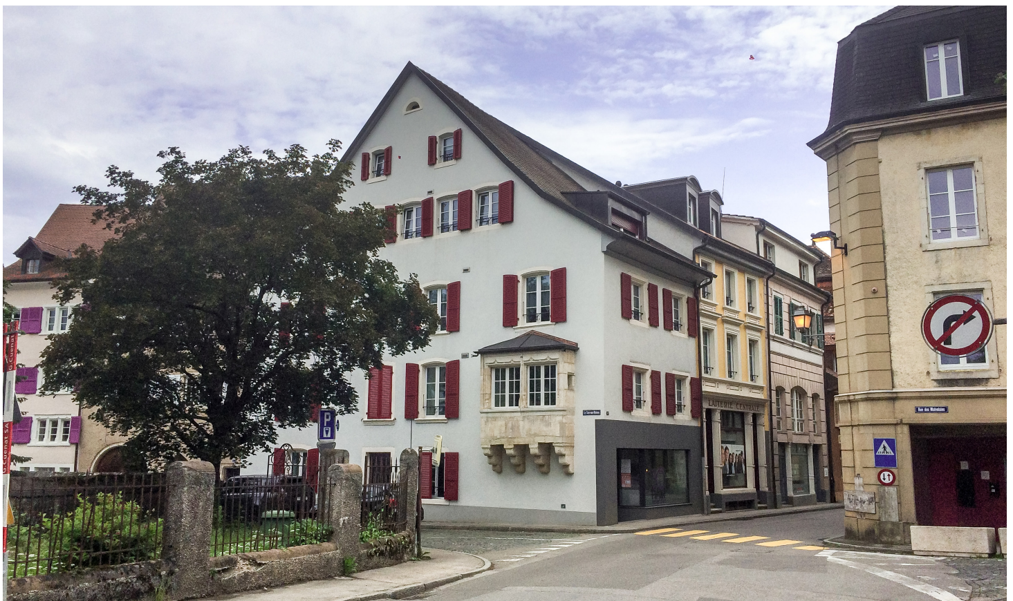
Die beiden Reihenhäuser im Vordergrund (ehemalige Molkerei) wurden durch ein gemeinsames Treppenhaus verbunden. Dadurch konnte ein Lift eingebaut werden, der zwei kleine Gewerbelokale und sieben neue Wohnungen erschliesst. Foto: A. Beuret, EspaceSuisse
