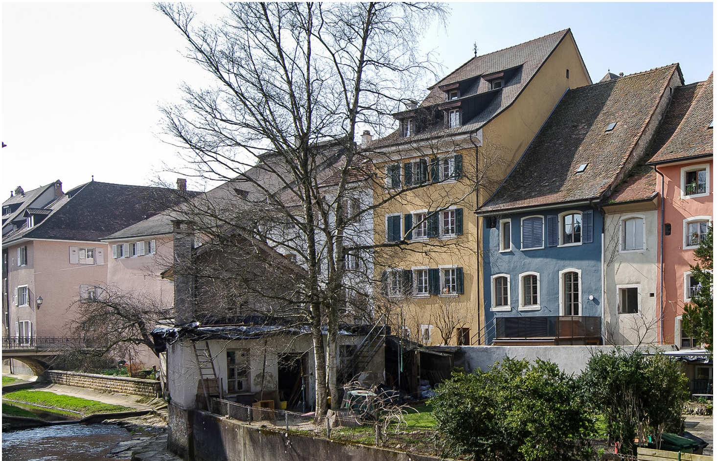
In den strassenseitigen Räumlichkeiten im Erdgeschoss und im ersten Geschoss des blauen Gebäudes ist ein Architekturbüro untergebracht. Auf der Seite, die auf den Fluss hinausgeht, wurde eine Duplex-Wohnung mit vier Zimmern und Terrasse gebaut. Foto: Burri & Partenaire
