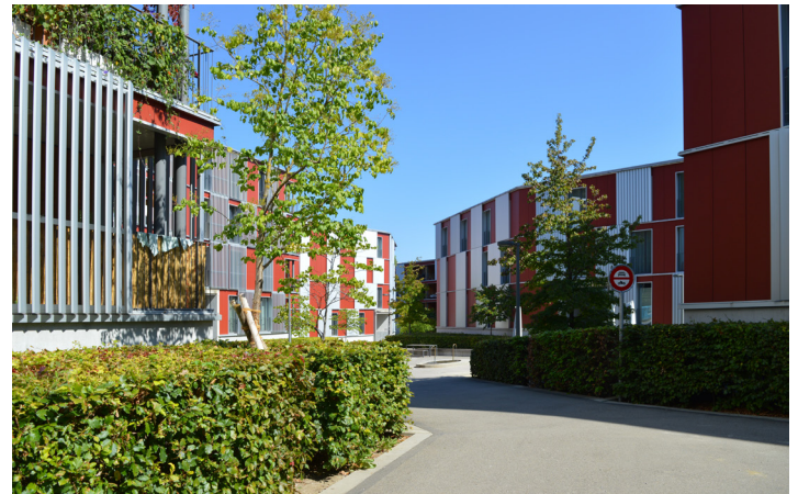
Verschiebbare Alu-Lamellenelemente vor den Fenstern dienen als Sicht- und Sonnenschutz und sorgen für ein ständig wechselndes Fassadenbild. Foto: L. Buchmann, HSR
