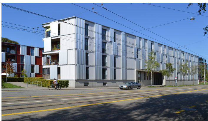
Ein langes Gebäude – bestehend aus drei zusammengebauten Mehrfamilienhäusern – schützt die übrige Siedlung vor Strassenlärm. Foto: L. Buchmann, HSR
