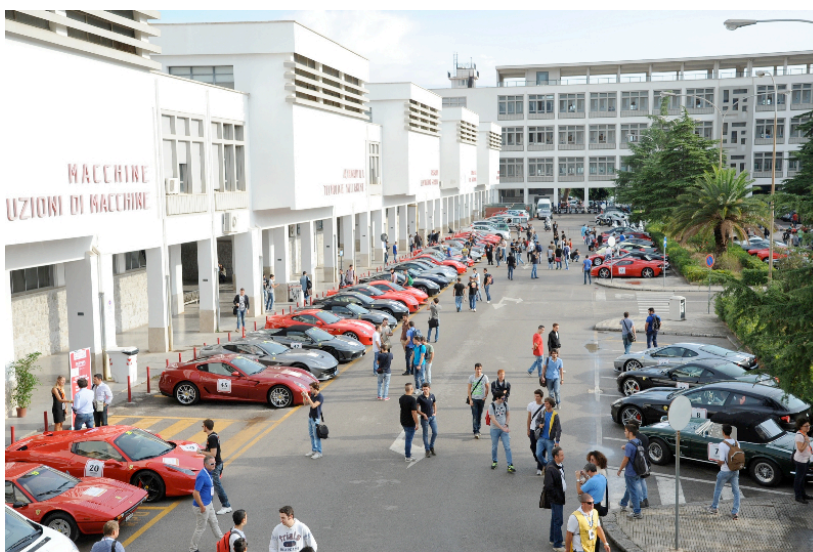
Abbildung 1 - Gebäude für das Department Maschinenbau und Aerodynamik
