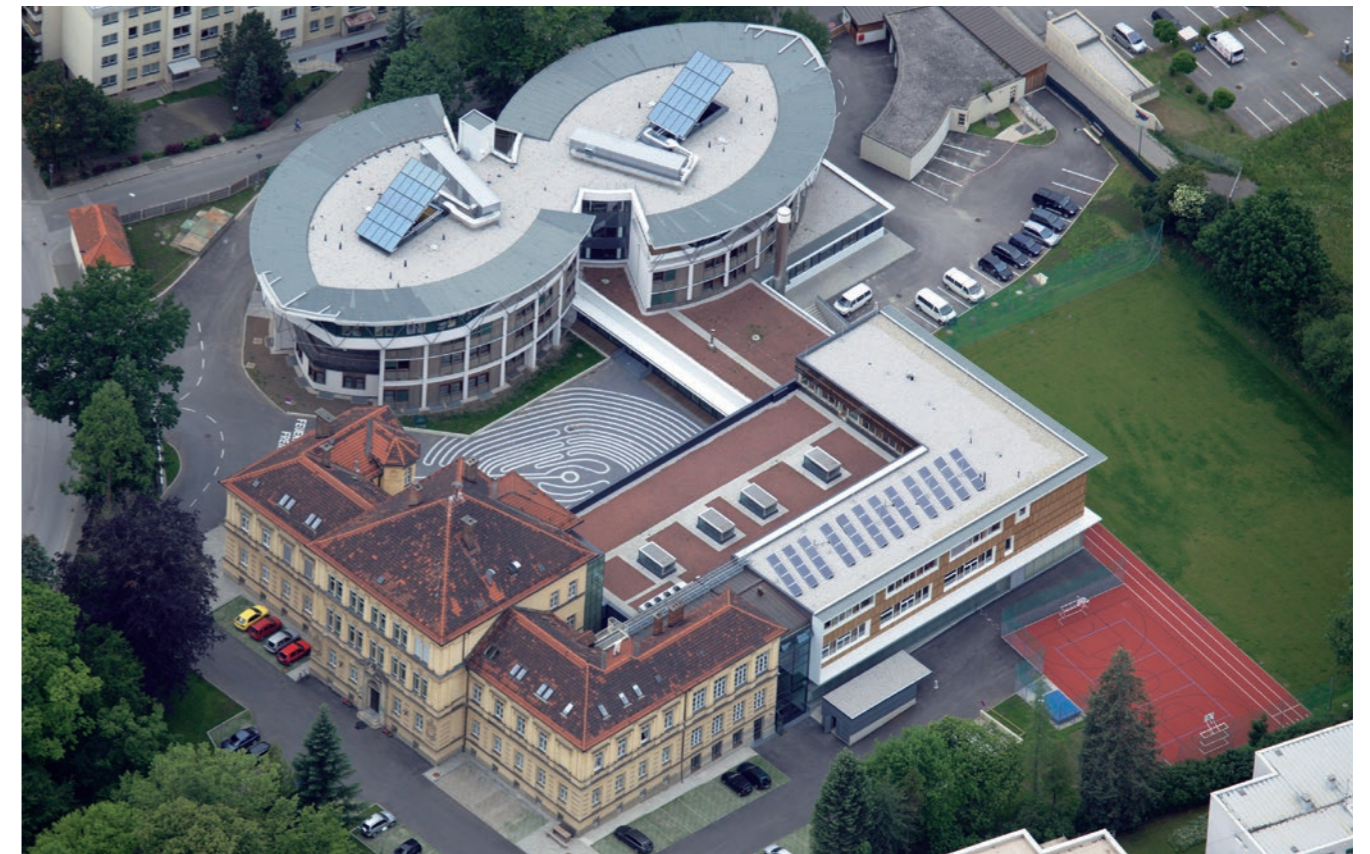
Der Schulcampus ist heute ein moderner, komplexer Multifunktionsbau mit Bio-Fernwärmeversorgung, teilautarker Strom- und Warmwasserversorgung mitten im Stadtgebiet.
