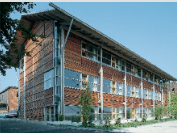
Ingenieurbüro und Verwaltung im Werk Niederkrüchten (Holzbaupreis 2000)
