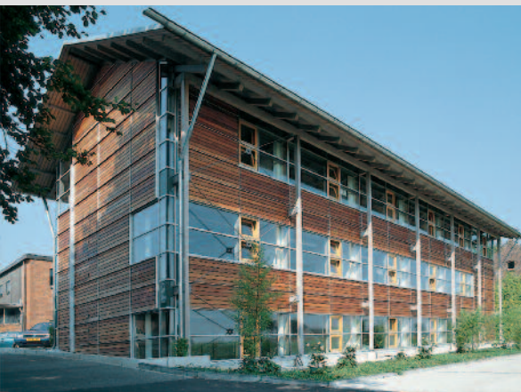
Ingenieurbüro und Verwaltung im Werk Niederkrüchten (Holzbaupreis 2000)
