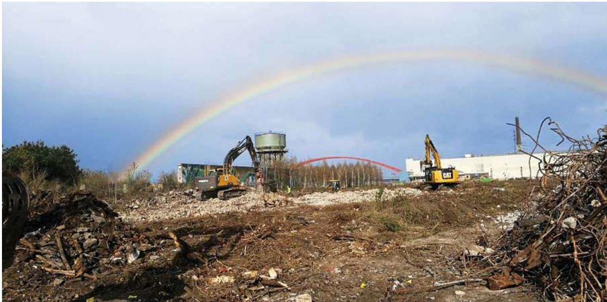
Der Rückbau und Abbruch einiger alter Bauwerke mit unterirdischen Gängen waren ebenfalls herausfordernd. Es musste für einen sicheren Grund der Baumaschinen gesorgt werden, um die Einsturzgefahr zu minimieren. Es wurde teilweise auch mit Seilzügen gearbeitet.
