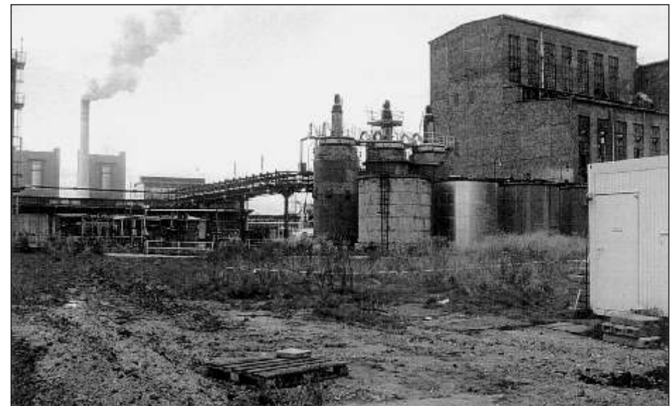
Bild 2 Blick auf die alte EPS-Anlage Bauten F 93 / F 993 im letzten Produktionsjahr 1996
