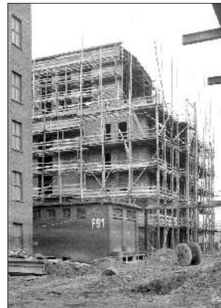
Bild 5 F 93 im Bau
