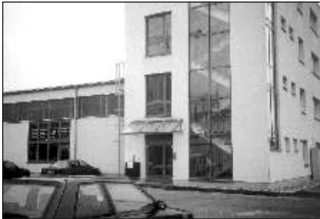
Bild 44 Bau H 108, F&E, Anwendungstechnik, Pilot- und Schaumtechnikum EPS
