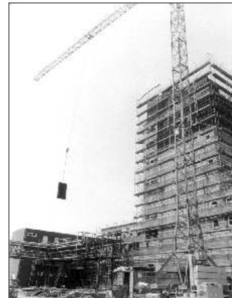
Bild 37 EPS-Neuanlage im Bau; Aufarbeitung Bau I 117
