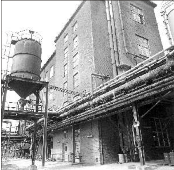
Bild 12 Abfüllstelle für PS-GM-Rohgranulat in F 59 zum Transport nach E 91
