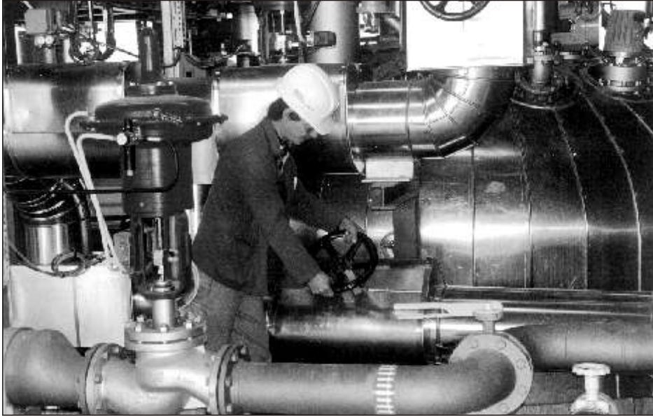
Bild 41 EPS-Neuanlage - Teilansicht Oberteil Pm-Reaktor, im Vordergrund U. MEINICKE
