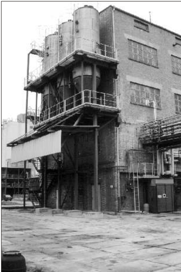
Bild 19 Blick auf die IVA-SAN Bau D 69x mit Granulat-Silos von SW
