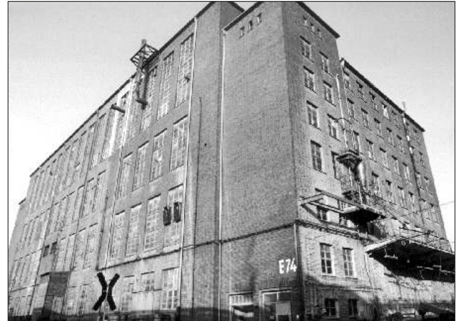
Bild 3 Blick auf Bau E 74 mit den Anlagen zur Herstellung von ABS und PAN
