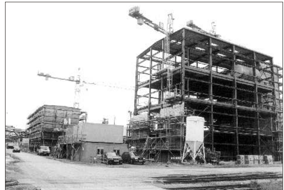
Bild 38 EPS-Neuanlage im Bau; Gebäude F 114 und I 119
