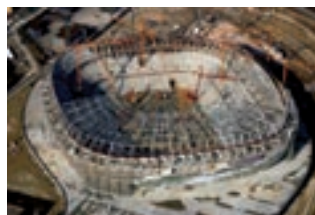
Die Allianz Arena wird ein Jahr vor der Fußball-Weltmeisterschaft eröffnet: 22 000 Tonnen verbauter Stahl.
