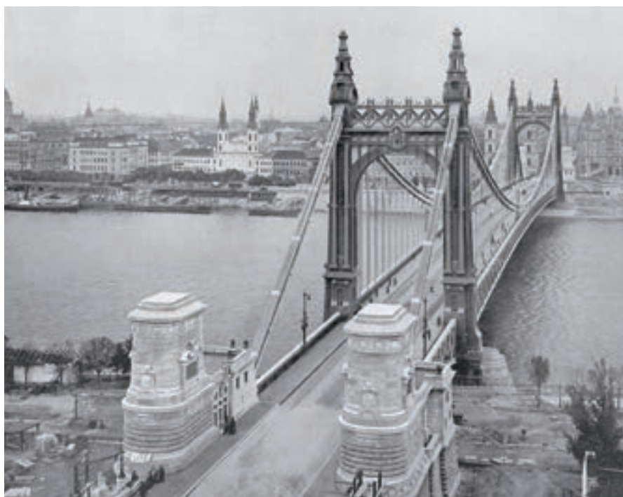
Eine der letzten historischen Kettenbrücken ist die 1898 bis 1903 erbaute Elisabethbrücke in Budapest. Die Erbauer entschieden sich bewusst für Ketten, weil diese – im Gegensatz zu Seilen – in Ungarn hergestellt werden konnten.
