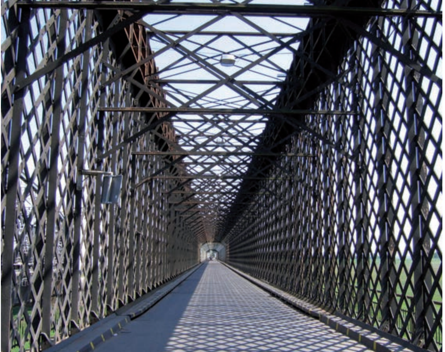
Eine der Gitterbrücken, die Johann Carl Wilhelm Lentze ab 1845 als Querung über Weichsel und Nogat bei Dirschau erbaute.
