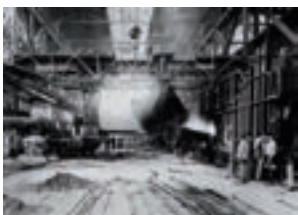
Der Siemens-Martin-Ofen macht es 1865 erstmals möglich, Schrott zu Stahl umzuwandeln.
