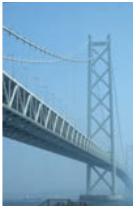
Mit einer Spannweite von 1991 Metern ist die Akashi-Kaikyo-Brücke in Japan die längste Brücke der Welt.
