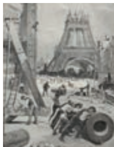
Die Stahlindustrie ist im 19. Jahrhundert auch ein nationales Prestigeobjekt: Der Eiffelturm in Paris wird – der Stabilität wegen – aus Puddeleisen gebaut.
