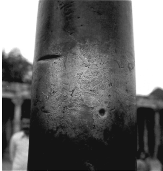
Bild 3.8: Die bis heute rostfreie Eisensäule von Kutub in Indien aus dem 9. Jahrhundert vor unserer Zeitrechnung. Die Säule hat ein Gewicht von 17 Tonnen.
