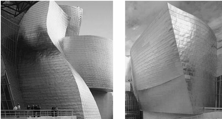
Bild 2.11: Zwei Ansichten von Frank O. Gehrys Guggenheim-Museum (Eröffnung 1997). Das Gebäude steht in Bilbao und hat eine Verkleidung aus Titan.
