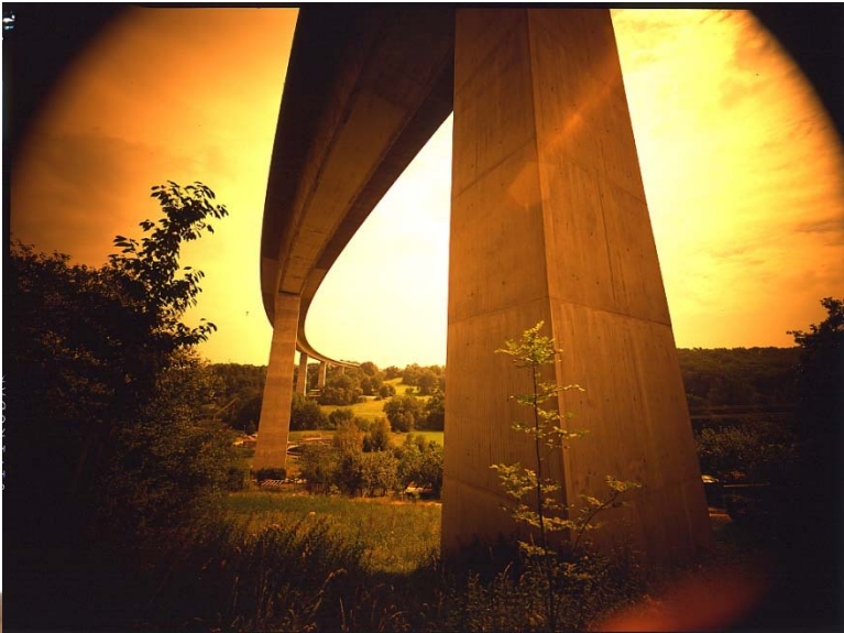
Brücke Stuttgart Korsbachtal
