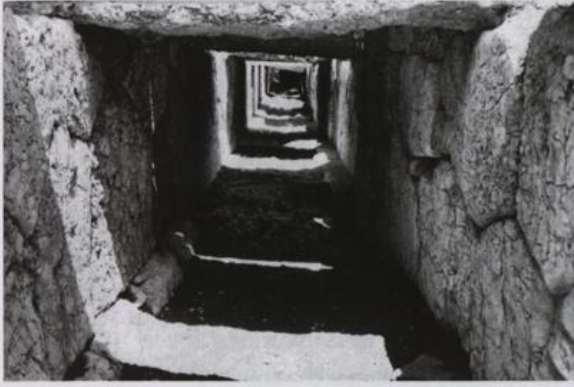
Im Inneren des Great Drain
