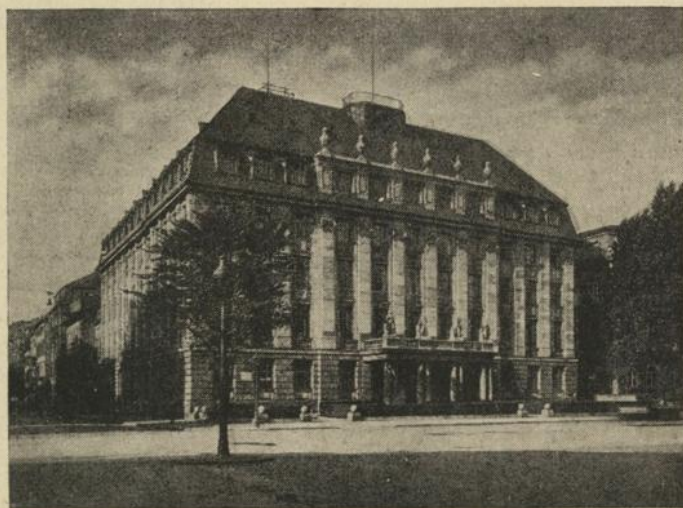
VERWALTUNGSGEBÄUDE IN FRANKFURT A. M.
