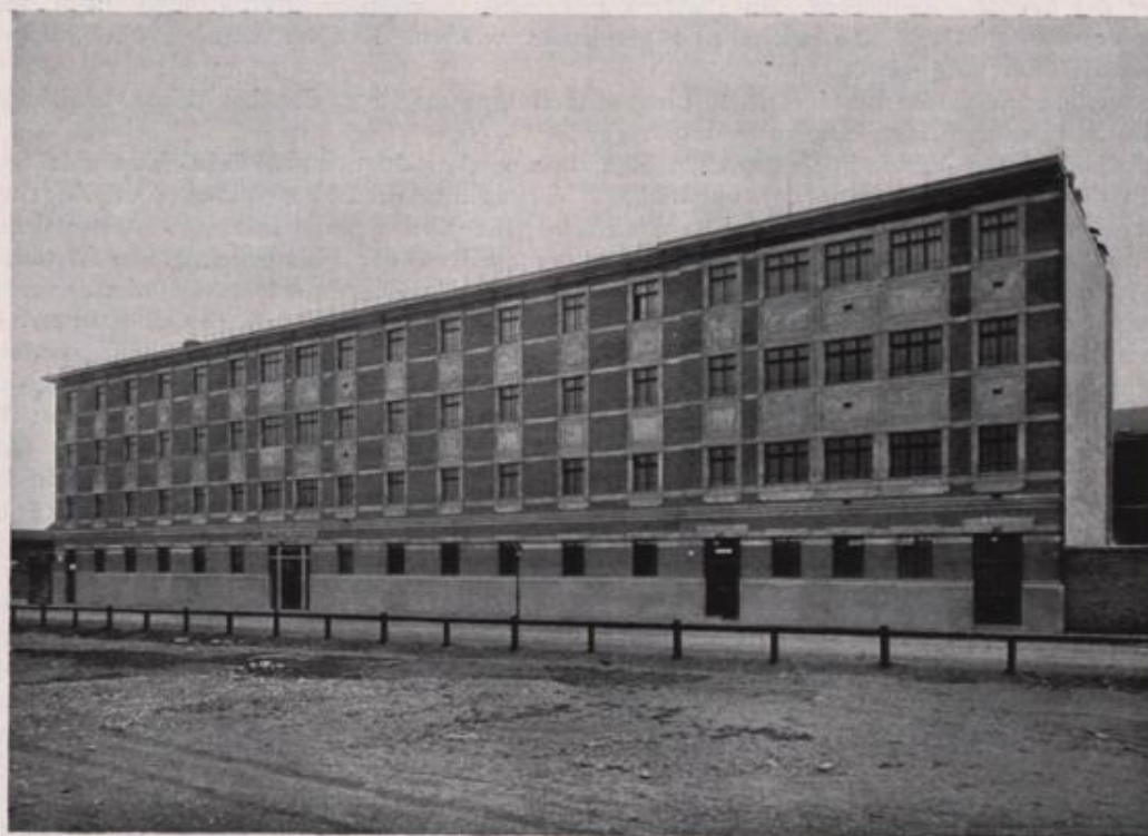
Asylzubau in der Gänsbachergasse
