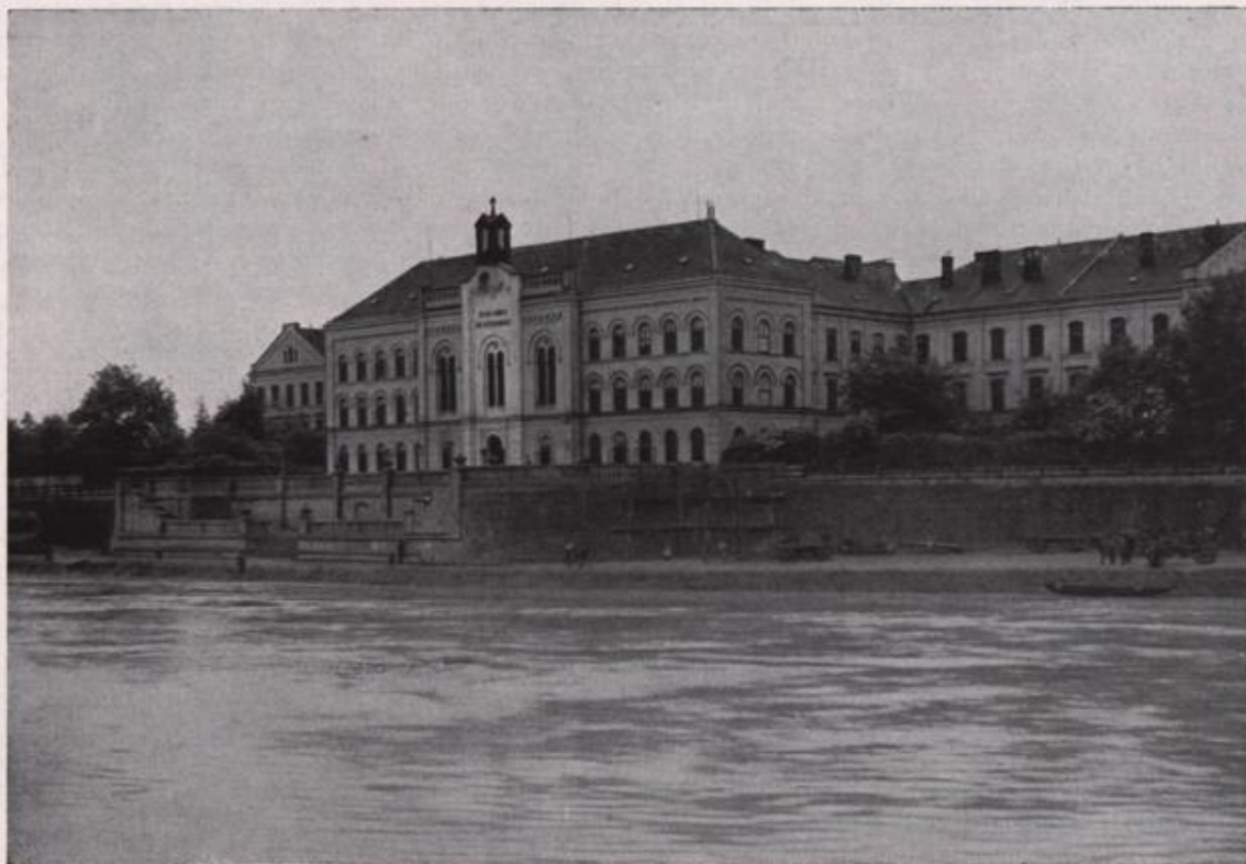
Heilanstalt Ybbs Ehemaliges Versorgungshaus
