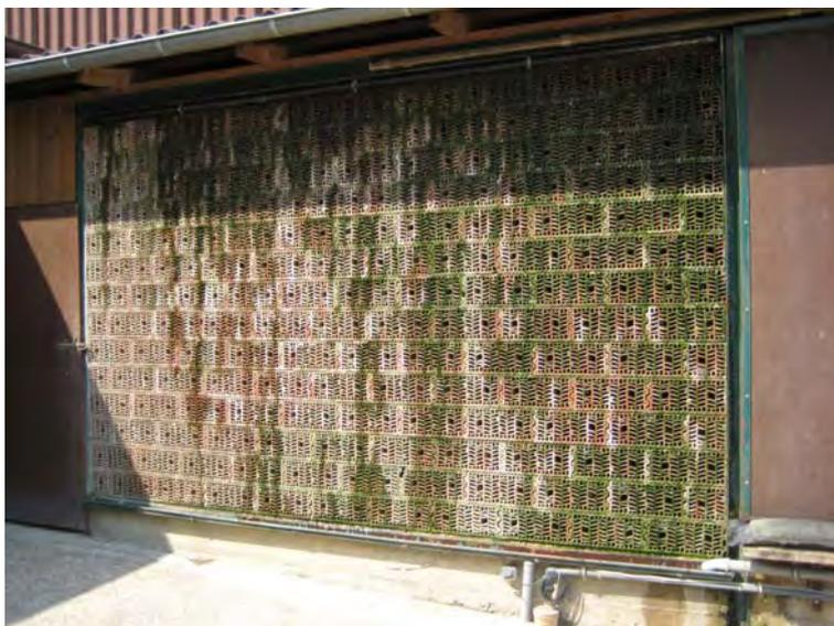
Abb. 9: Evaporationskühlung bei zentraler Frischluftansaugung mit Hilfe einer berieselten Wand aus quer aufgemauerten Lochziegeln
