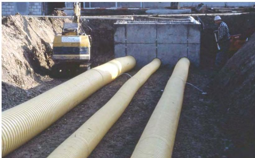
Abb. 6: Verlegung von Rippenrohren für einen Erdwärmetauscher
