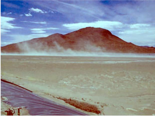
**Abb. 3.3** Vom Wind sichtbar verwehte Tailings aus einer Tailings-Deponie im Paradise Peak Mine Area, Nevada, USA (Nash 2005:21) .
