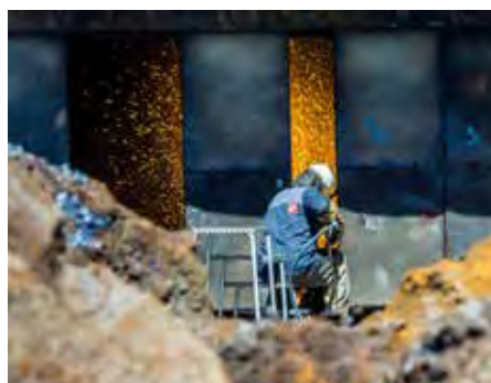
Jedes Teil wird bis auf die passende Größe für den Lichtbogenofen verkleinert.
